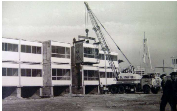
Fig.15.Montaje de la segunda planta.
