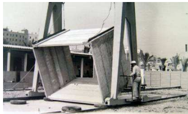
Fig.12. Momento del volcado y el EM sobre los carritos
