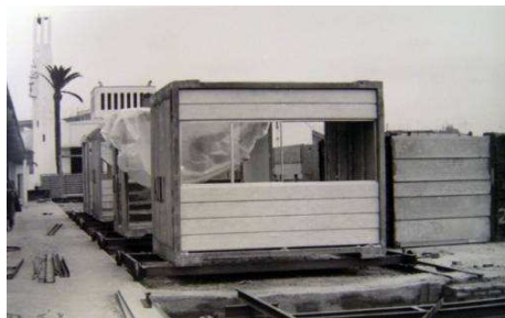
Fig.12. Momento del volcado y el EM sobre los carritos
