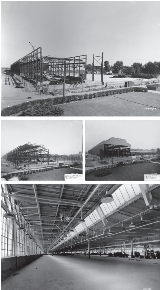
Figura 12. Secuencia fotográfica de la construcción de la Press Shop de la fábrica De Soto y foto interior de la Half Ton Truck Plant de Chrysler.
