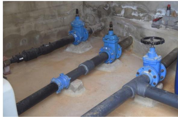
*Figura 11: Depósito principal en activo y válvulas*
