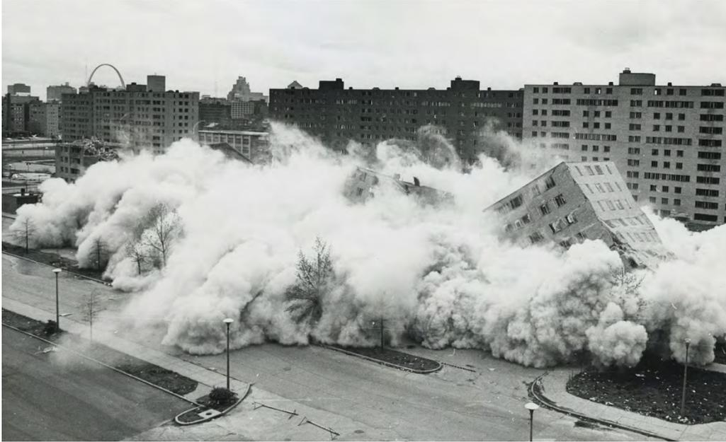
*Fotografía 17.—Proceso de demolición. Fotograma 3
