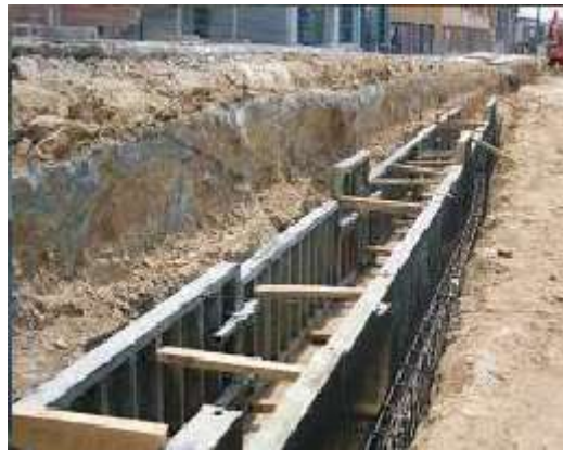
Ilustración 19 Encofrado de viga guía Fuente Madrid.org
