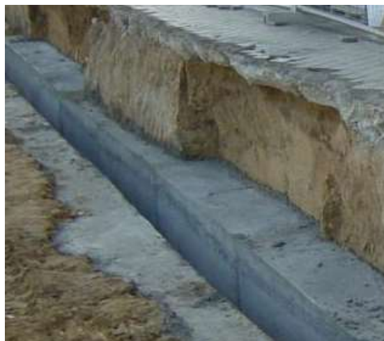
Ilustración 20 Viga guía después de hormigonado y desencofrado. Fuente forexsa.es
