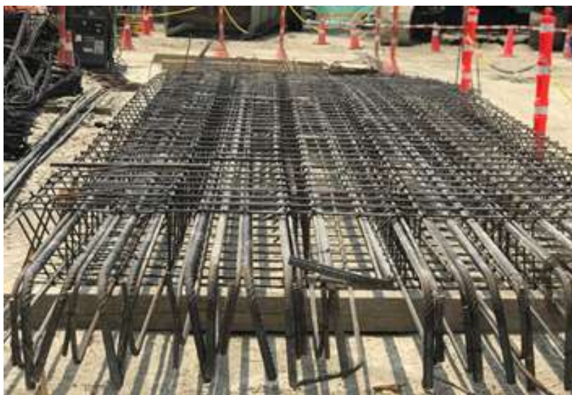
Ilustración 21 Ejemplo de armado de parrillas Fuente Toma propia
