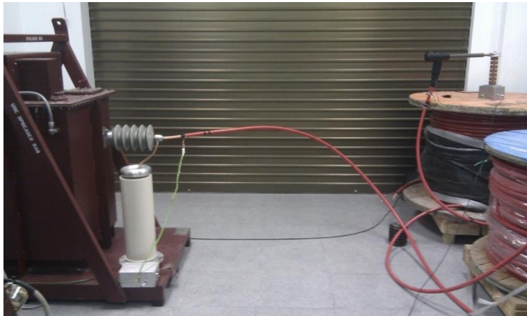
Figura 173. Vista de la conexión de alta tensión y del extremo del cable con el sensor capacitivo de gran ancho de banda, [ep].
