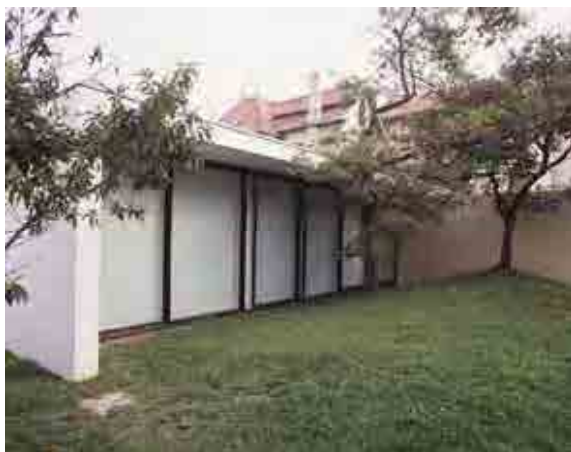
Casa Nevogilde 1, 1985. Vista del alzado de los dormitorios.
