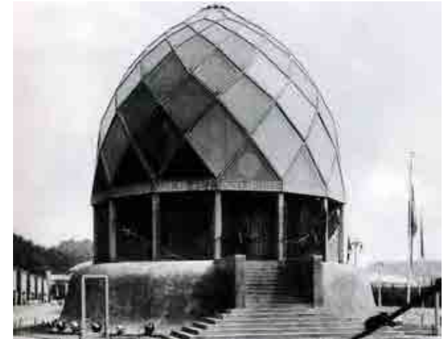
Pabellón de Cristal, exposición de la Werkbund en Colonia, 1914. Bruno Taut. Fotografía exterior.
