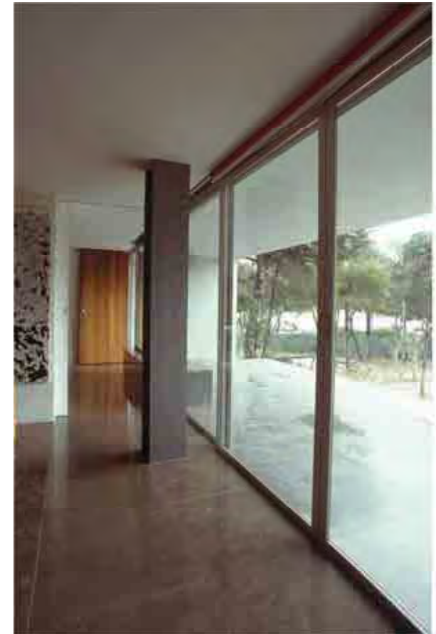
Casa de Cascais, 2000. Vista de la carpintería.
