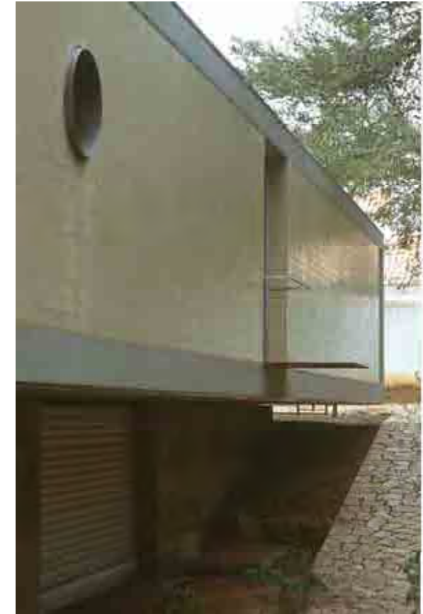
Casa de Cascais, 2000. Vista de la fachada trasera.
