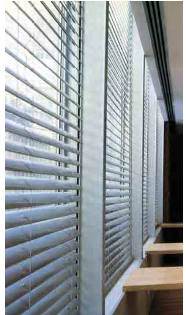
Casa das Artes, SEC, 1991. Vista del ventanal de la biblioteca.
