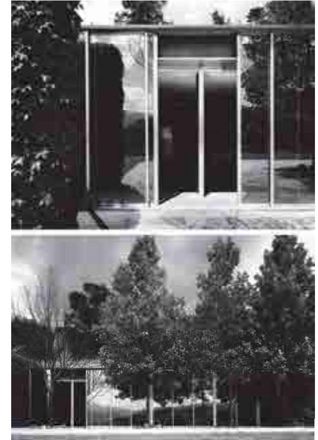
Casa em Baião, 1993. Vista del alzado principal y las carpinterías de aluminio.
