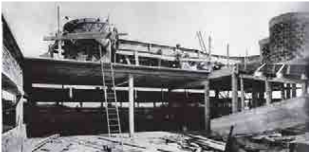
Villa Savoye. Fotografía de la terraza y el ventanal del salón durante las obras. Extraída del libro Le Corbusier Le Grand .
