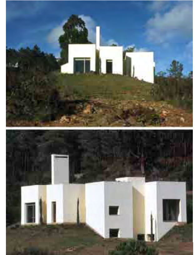
Casa da serra da Arrabida, 2002. Vistas exteriores.
