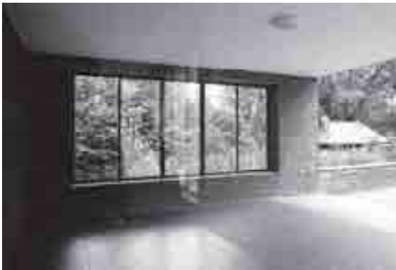
Casa Esters. Porche del comedor visto desde el interior de la casa.
