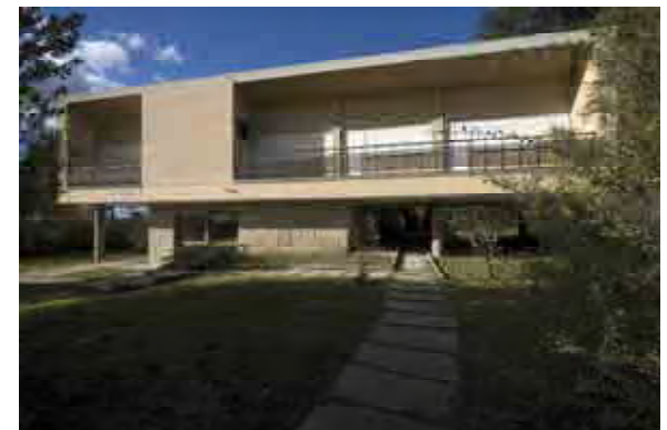
Presa de Picote. Casa para personal dirigente. Vista actual del volumen principal. Fotog. Luís Ferreira Alves.
