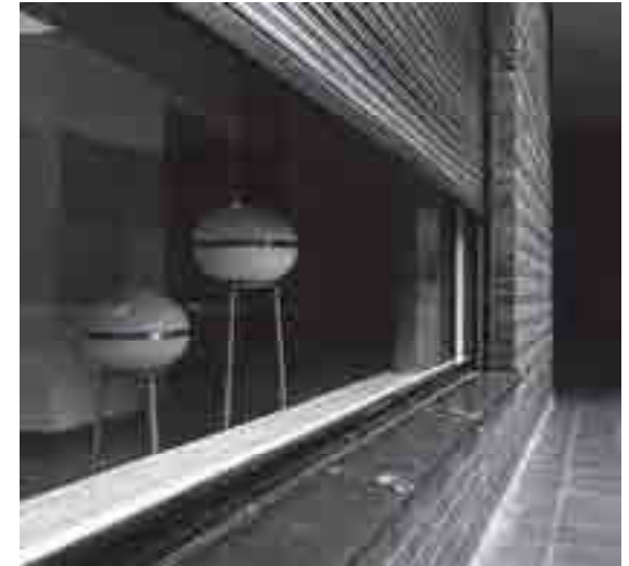
Casa Lange. Vista de detalle de ventana.
