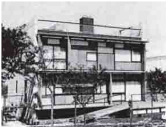
Casa Joaquim Costa, 1950. Fotografia de la fachada de levante. Arq. Celestino Castro
