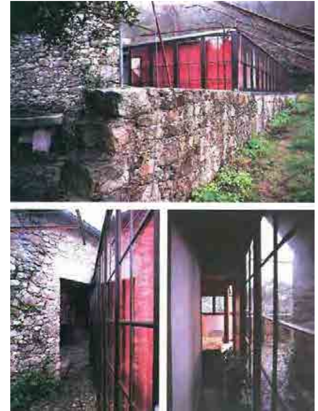
Casa Alcino Cardoso, 1973. Vistas de la fachada acristalada desde el exterior.
