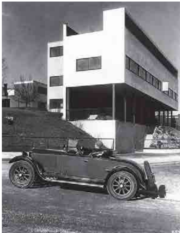
Weissenhof Siedlung. Fotografía exterior de las casas pareadas.
