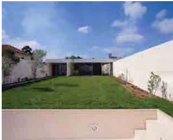
Casas Patio, 1999. Vista del alzado al patio principal.
