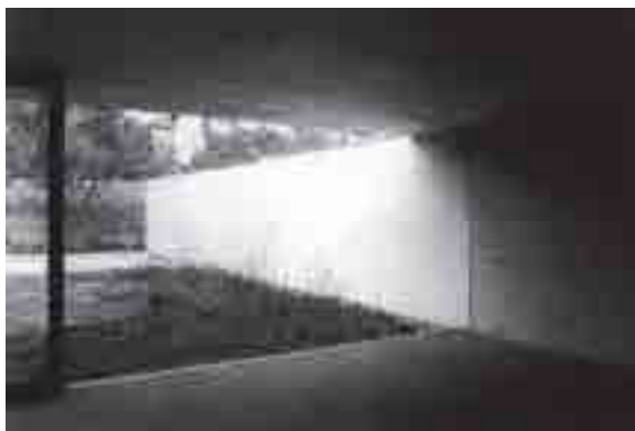
Casa Nevogilde 1, 1985. Vista de detalle del gran vidrio fijo sin carpintería.
