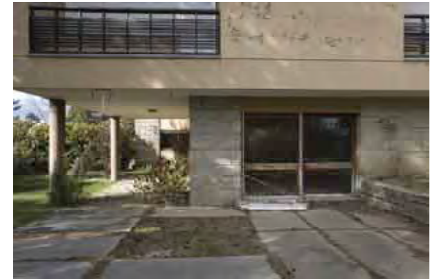
Presa de Picote. Casa para personal dirigente. Vista exterior de ventana de la sala. Fotog. Luís Ferreira Alves.
