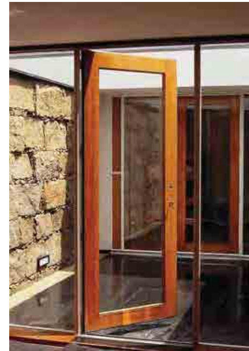
Casa Dos en el lugar de Varzea, 1993. Vista del ventanal del dormitorio. Detalle de la puerta exterior del dormitorio.
