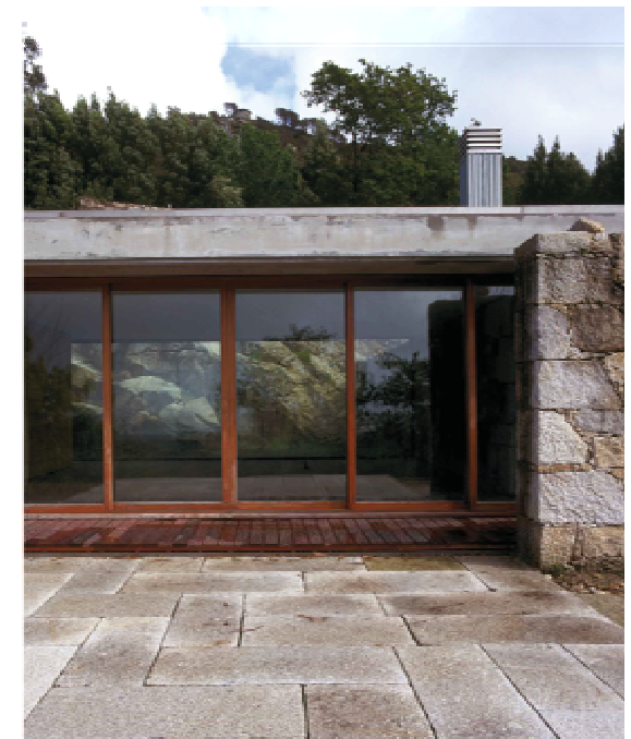
Casa en Moledo, 1998. Vistas del alzado delantero con las carpinterías de madera.
