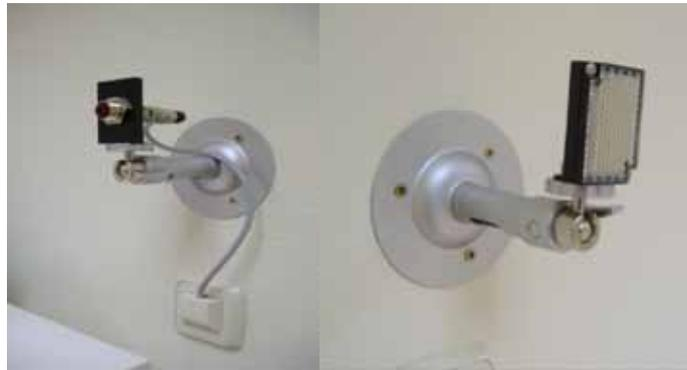
Figura 83. Detalle fotocélula (izquierda) y catadióptrico (derecha)
