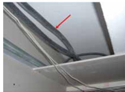
*Figura 94. Detalle del conducto utilizado para las canalizaciones del cableado*
