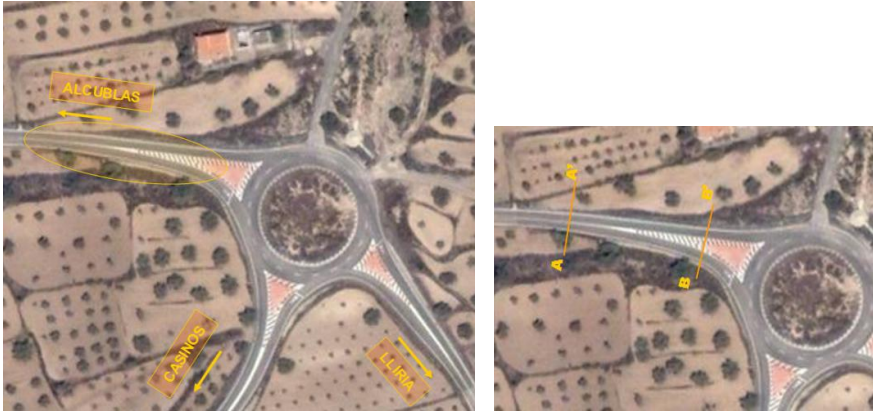
Figura 7.2 Control 1. CV-245 [Glorieta Casinos – Alcublas]
