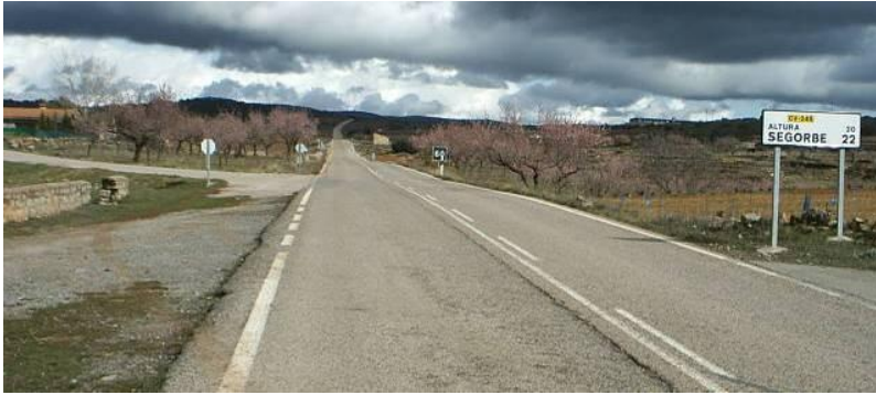
Figura 7.17 Instalación del control Alcublas norte
