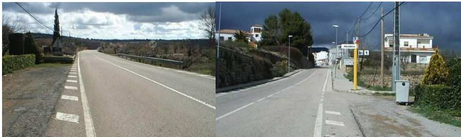
Figura 7.8 Instalación del control Alcublas sur
