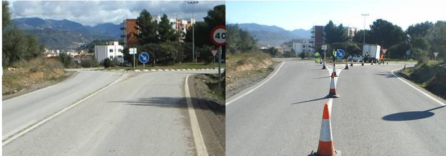
Figura 7.18 Instalación del control de Altura
