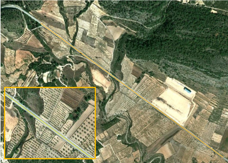
Figura 7.48 Detalle de la recta situada en el entorno del PK 2+000 del tramo 1 no identificada por el ajuste de curvaturas con R_{\text{máx}} = 8000 m
