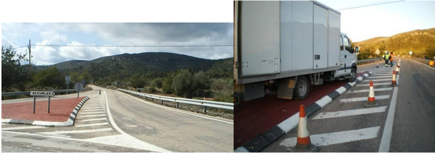
Figura 7.7 Instalación del control glorieta
