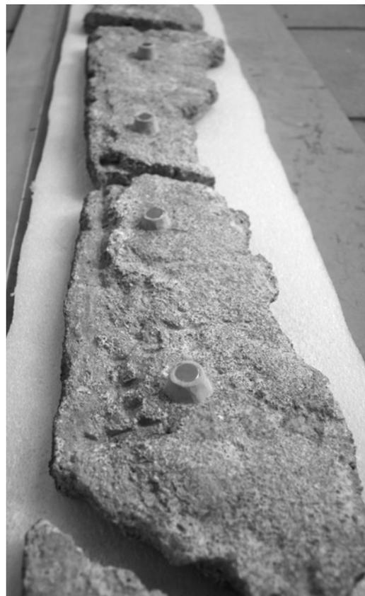
cas presentan unos orificios donde se aprecian los restos ya oxidados de los pernos metálicos de hierro empleados como sistema de anclaje de los mármoles, dos por placa.
