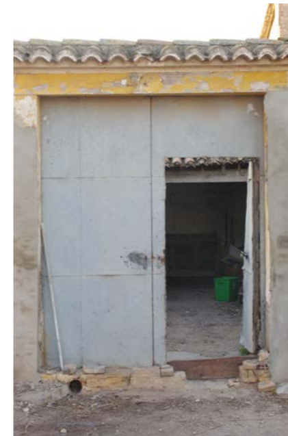
Fig. 4: Puerta acceso corral (PA2)
