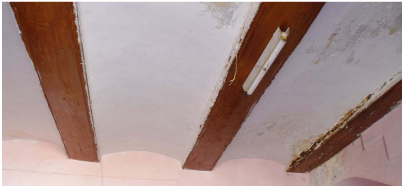
Fig. 1: Forjado de vigas de madera y revoltones visto desde el recibidor
