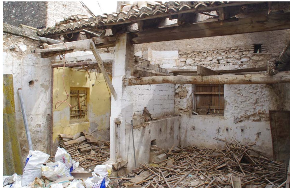
Fig. 17: Vista del patio interior
