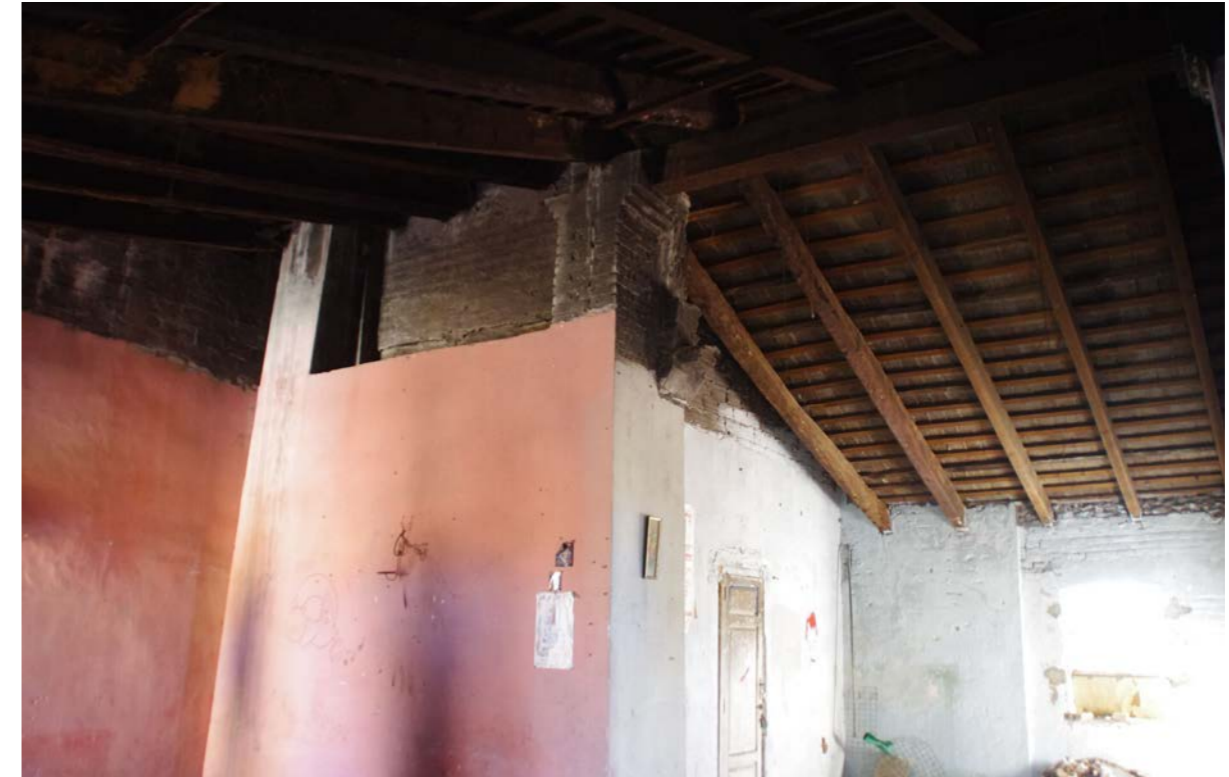
Fig. 18: Cambio de altura de la cubierta en la zona anexa
