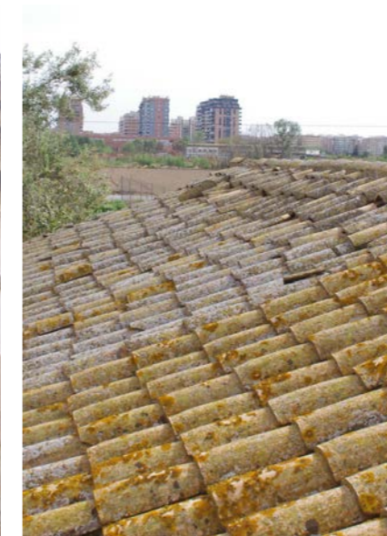
Fig. 3: Cubierta teja árabe
