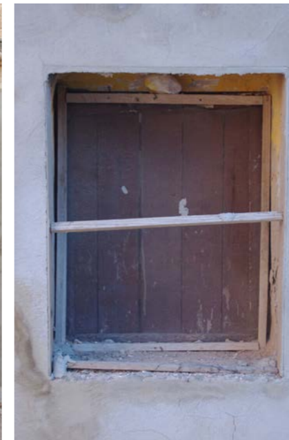
Fig. 5: Ventana cocina ext. (V2)
