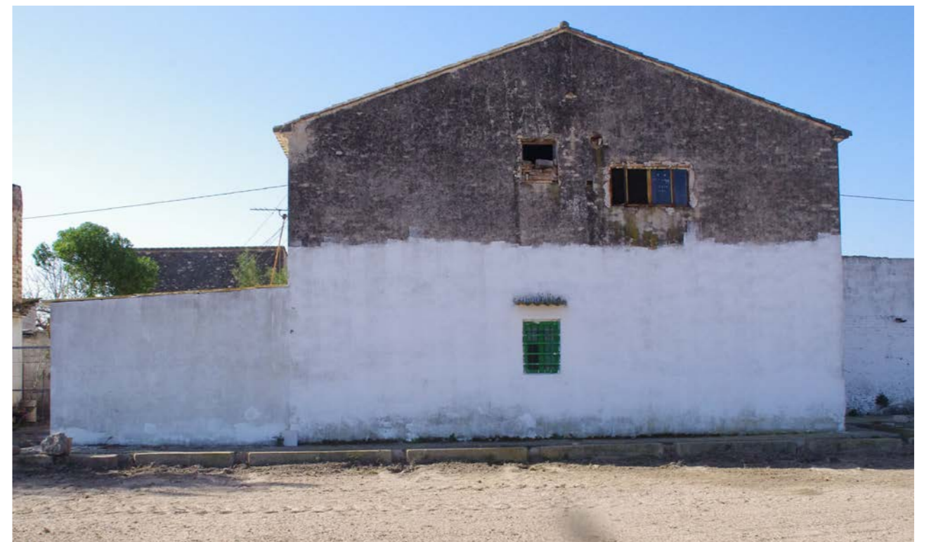
Fig. 10: Fachada del volumen ocupado por las dos viviendas anexas
