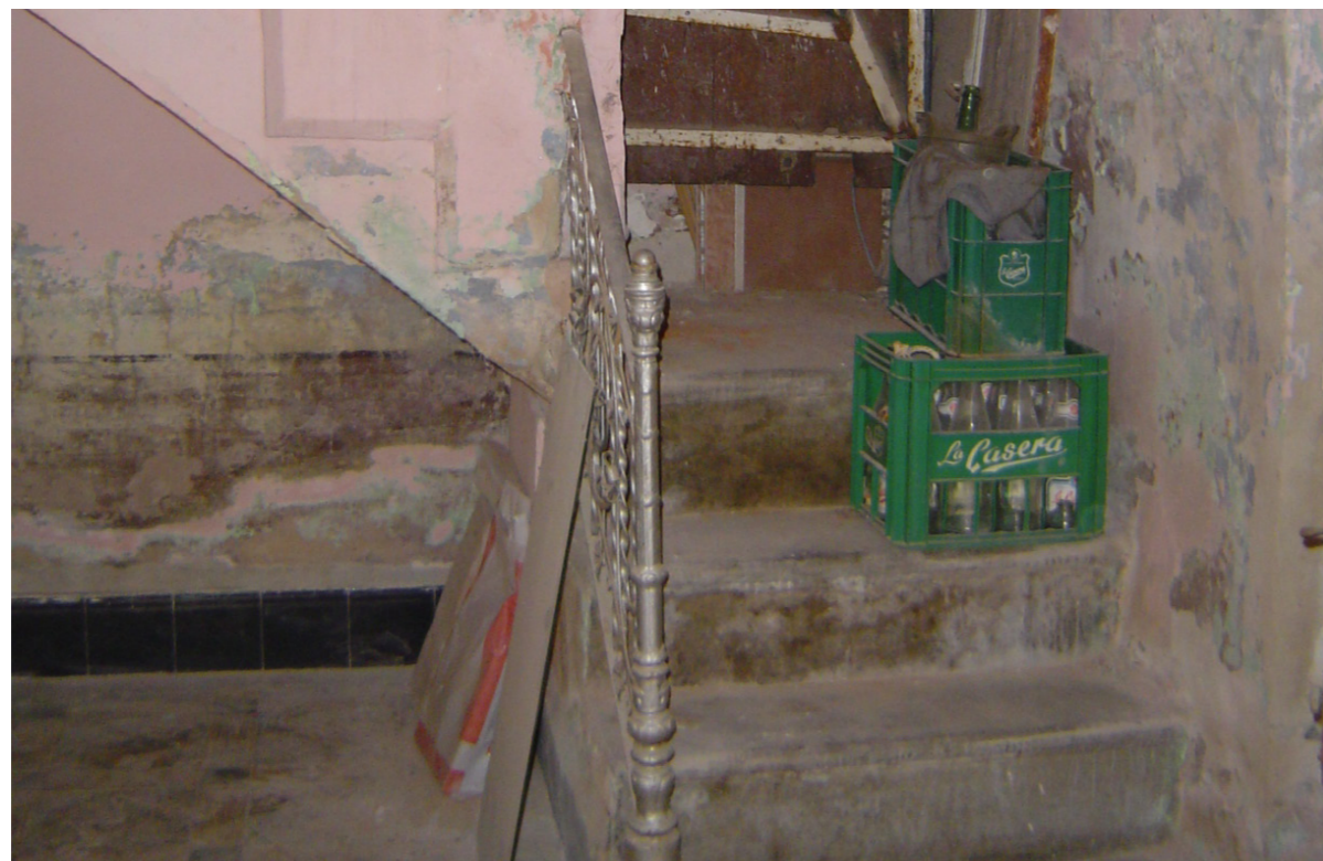
Fig. 10: Escaleras de acceso a la planta superior
