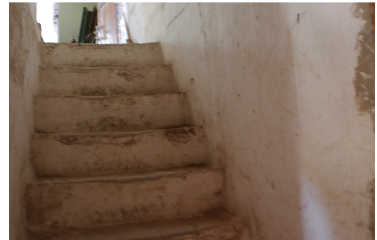
Fig. 12: Escalera desde el interior
