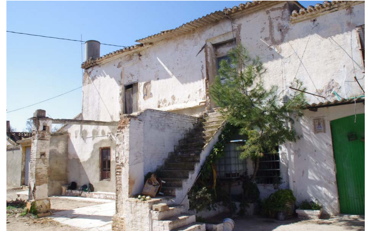
Fig. 7: Escalera de acceso planta superior zona anexa
