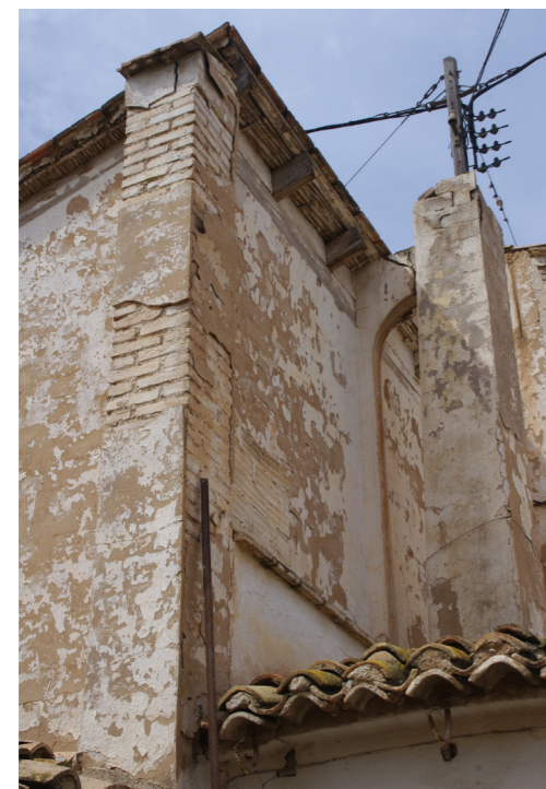
Fig. 5: Pilar de ladrillo
