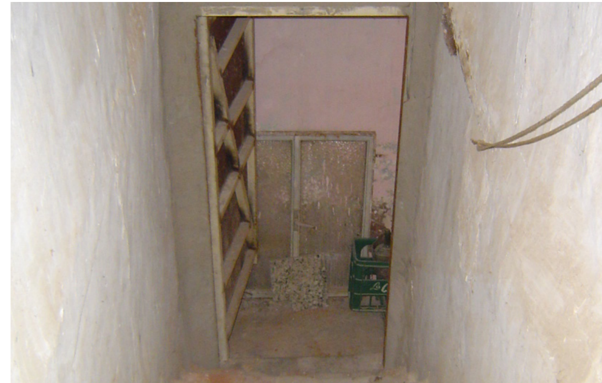
Fig. 11: Escalera desde arriba
