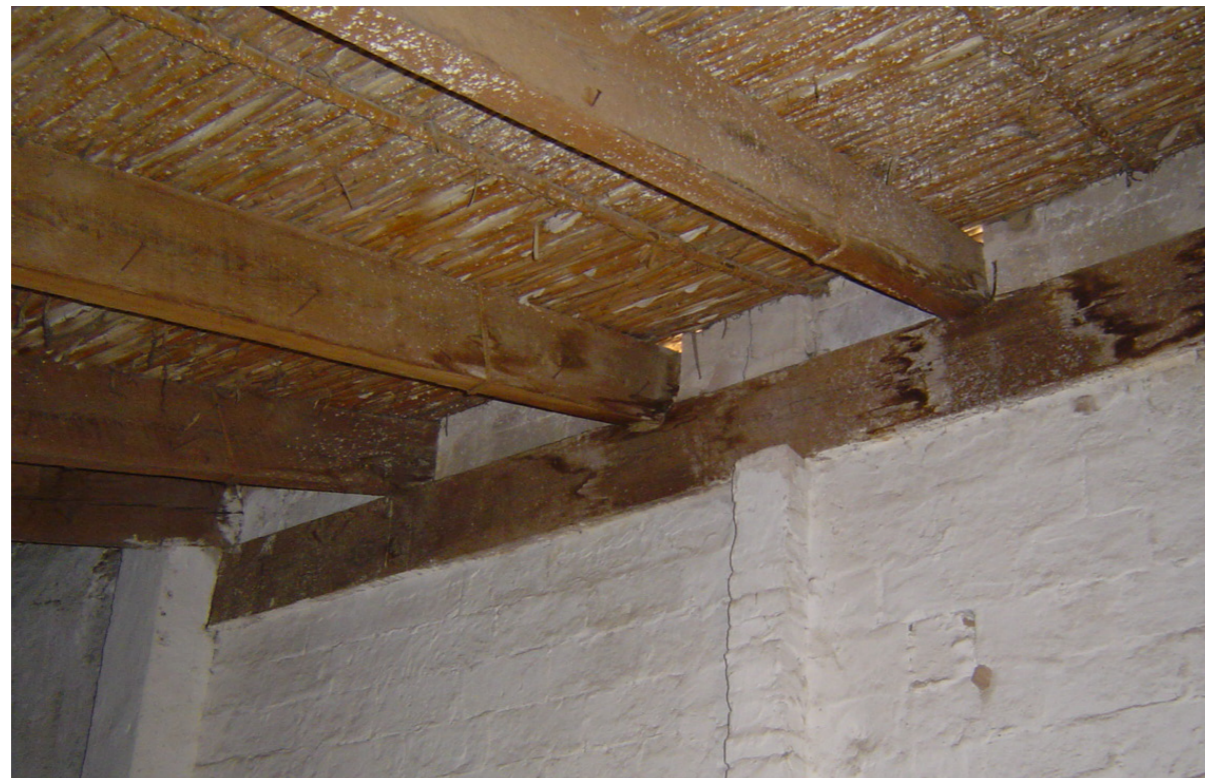
Fig. 25: Cubierta de cañizo
