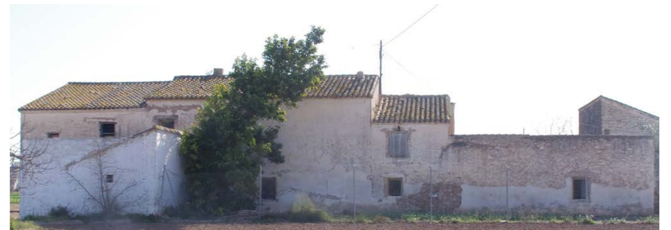
Fig. 5: Fachada Oeste (Posterior)
