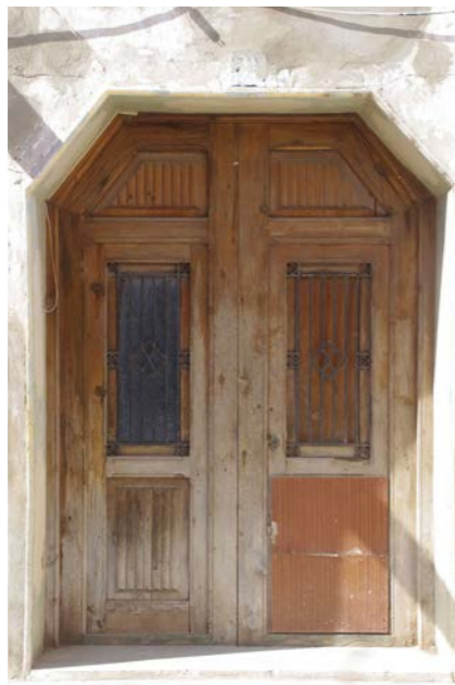
Fig. 1: Puerta de acceso principal (PA1)
