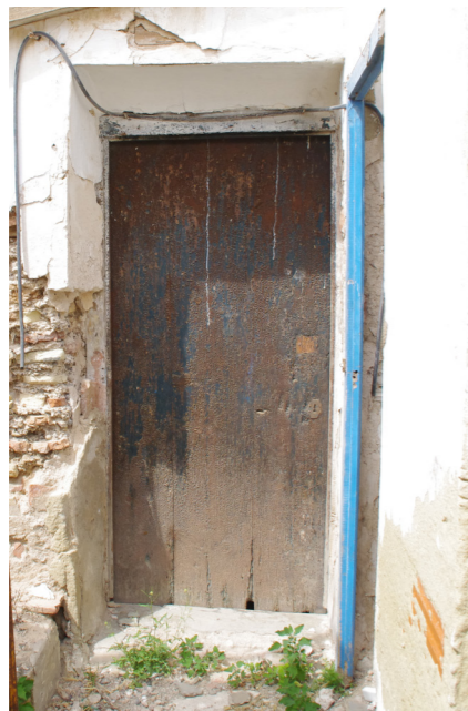
Fig. 4: Puerta acceso cocina
