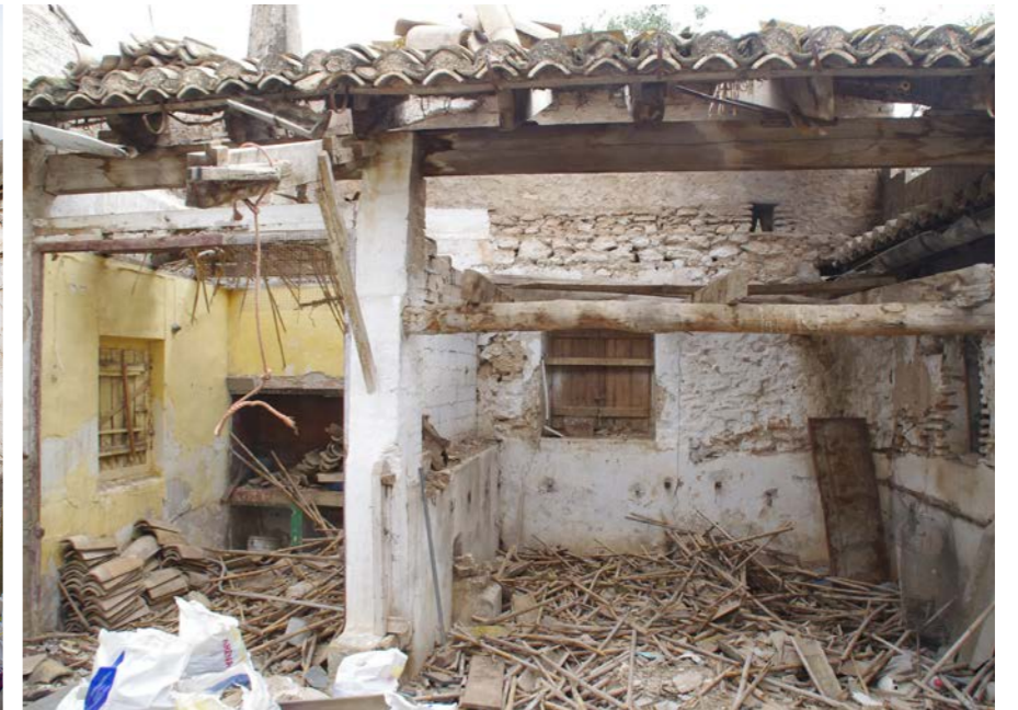
Fig. 13-14: Cocina y almacén patio exterior
