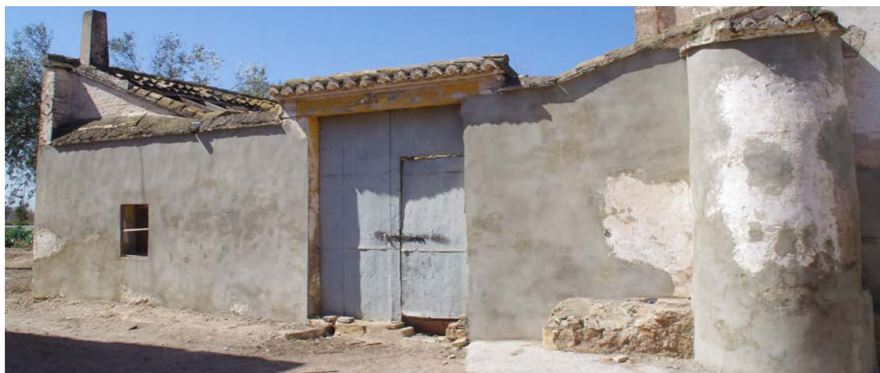
Fig. 1,2,3: Fachada Este (Principal)
