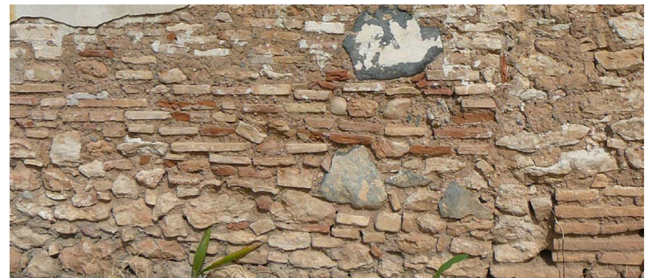
Fig. 2: Muro de carga mixto
