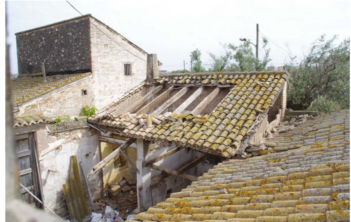
Fig. 26: Vista de las cubiertas del patio
