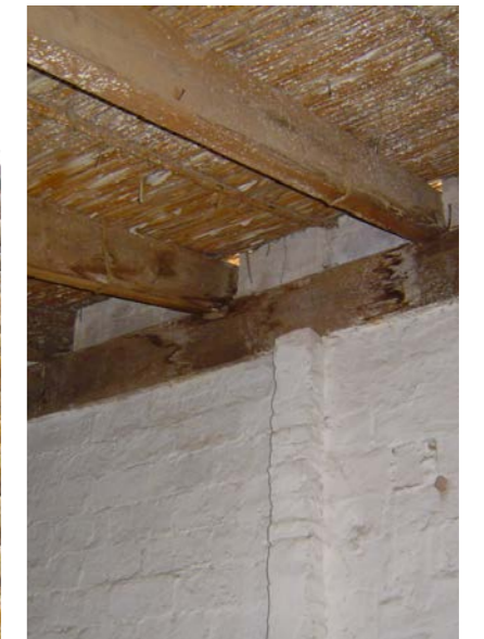
Fig. 4: Sistema de cañizo sobre viguetas
