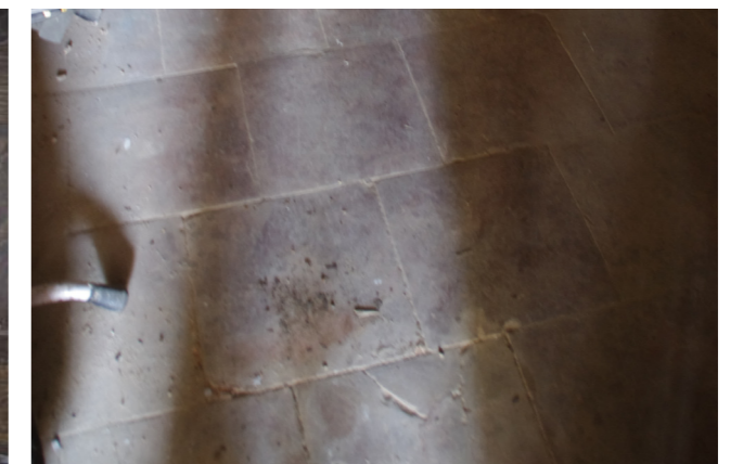
Fig. 2: Pavimento de rasillas
