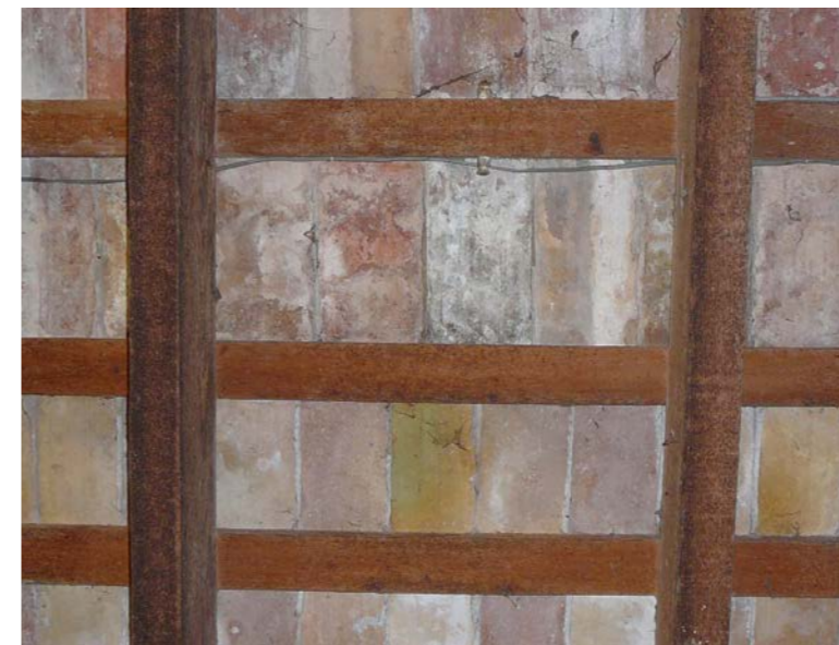
Fig. 2: Forjado entabicado de rastreles y rasillas
