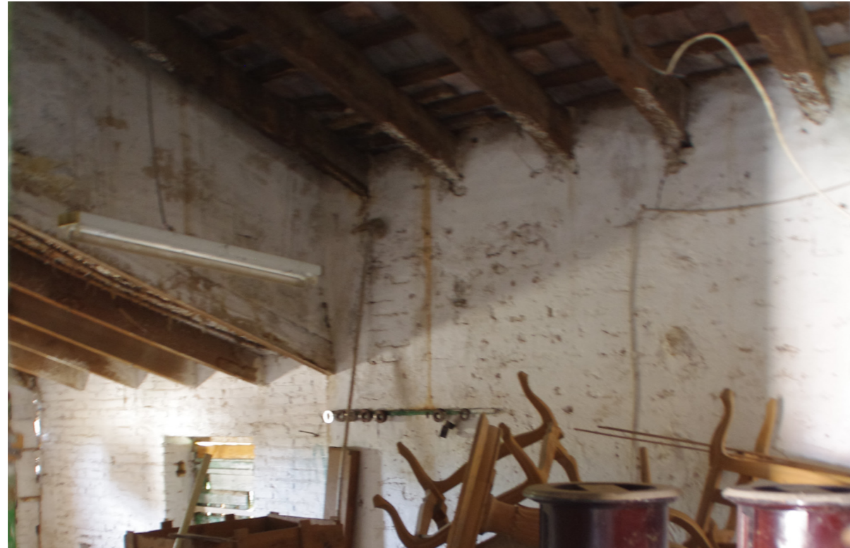
Fig. 24: Cambio de altura entre las cubiertas de la alcoba
