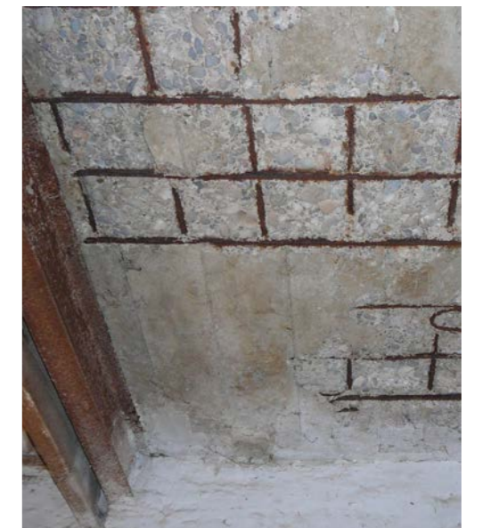
Fig. 3: Macizado de refuerzo forjado cuadra
