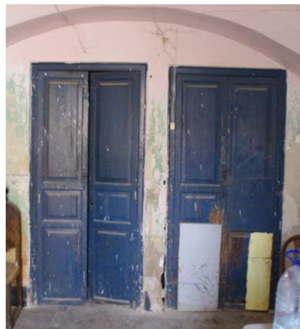
Fig.1: Puertas acceso dormitorios 1 y 2
