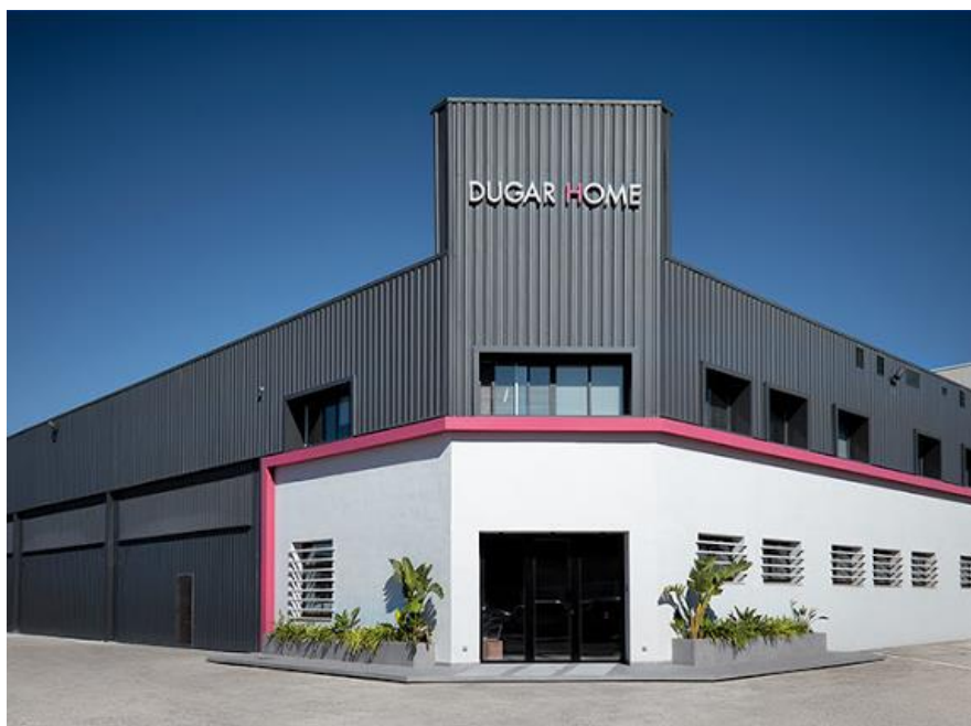
Imagen 4 Nave industrial de la empresa (Imagen cedida por la empresa)
