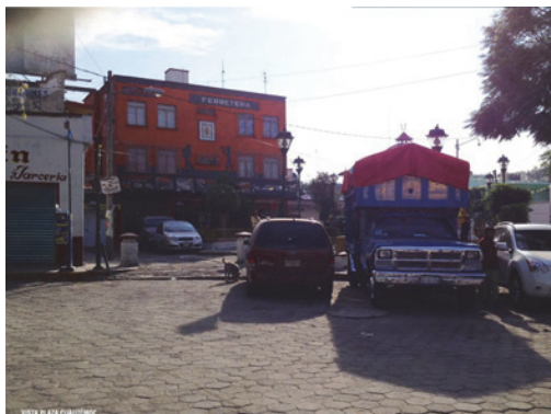
Fig. 10. Estado Inicial (arquitectos: Adriá - Polo - Tepichín)
