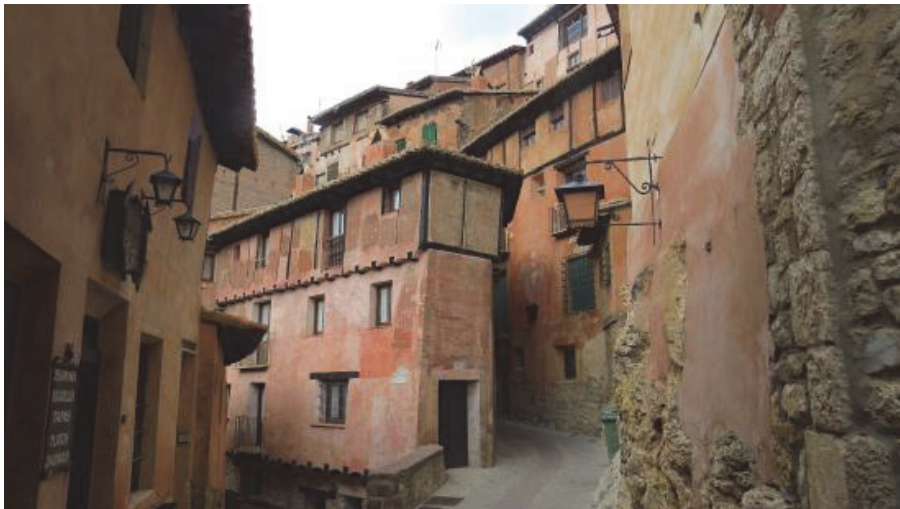
Fig. 7. Recuperación de edificios residenciales en el casco histórico de Albarracín
