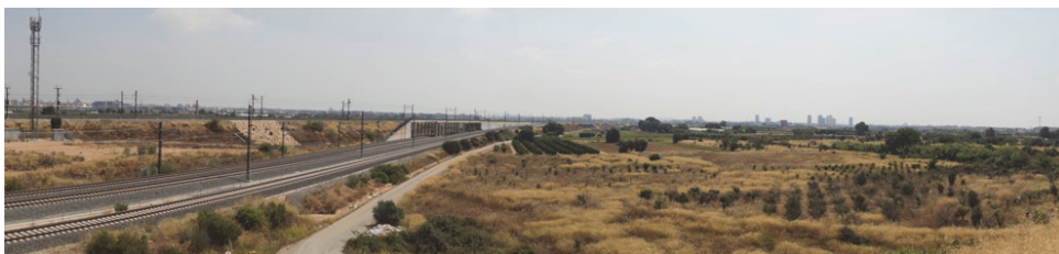
Fig. .5 Las formas de las infraestructuras de transporte rompen la estructura rural de la propiedad rural produciendo procesos de abandono y degradación de los espacios de borde: ejemplo del ferrocarril de alta velocidad en L'Horta Sud
