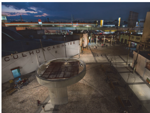
Fig. 11. Estado Final (arquitectos: Adriá - Polo - Tepichín)
