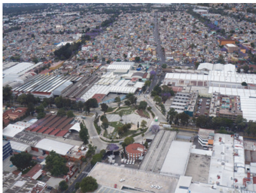
Fig. 8. Estado Final de La Glorieta (arquitectos: Interior 137)
