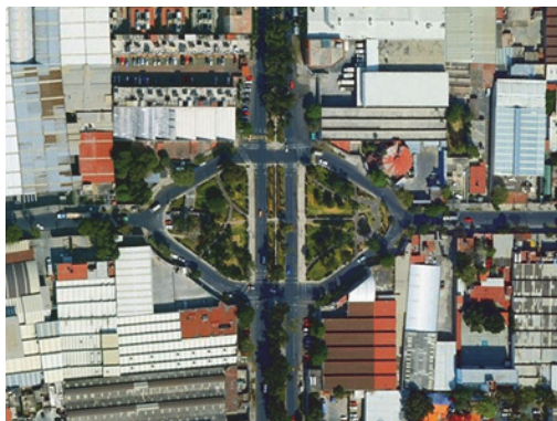
Fig. 7. Estado Inicial de la Glorieta (arquitectos: Interior 137)
