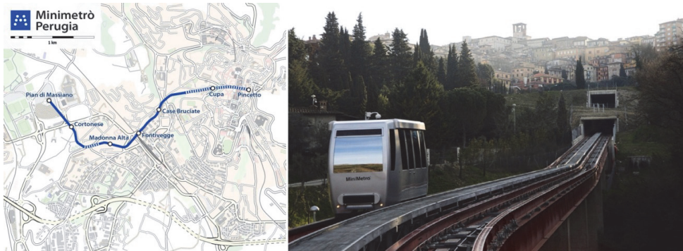
Fig. 16. Minimetro de Perugia, plano de la línea y vista de los túneles de ascenso al casco histórico. (Fuente: Comune di Perugia)
