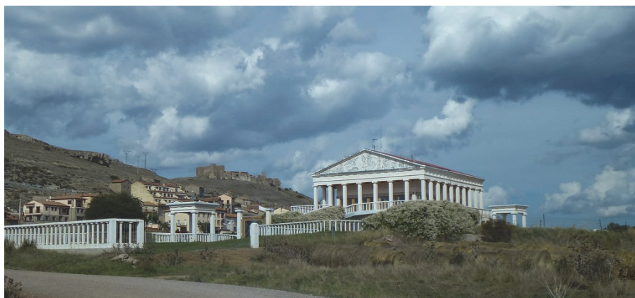
Fig. 6. El “Partenón” de Cedrillas, construcción extemporánea y deslocalizada rayando lo kitsch. Ver Vargas (2014)
