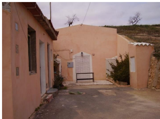
Figura 199. Terreno revestido sin fachada adosada. Cueva 01_03_30 de La Algueña
