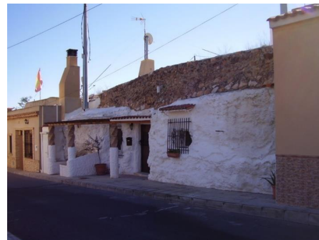
Figura 197. Terreno revestido sin fachada adosada. Cueva 02_01_6A de La Algueña
