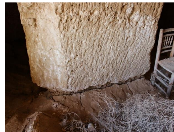
Figura 394. Lavado de la base del muro (terreno). Cueva 18_01_02 de Monóvar
