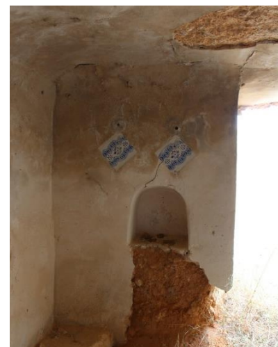
Figura 273. Revestimiento encalado. Cueva 02_01_04 de Petrer
