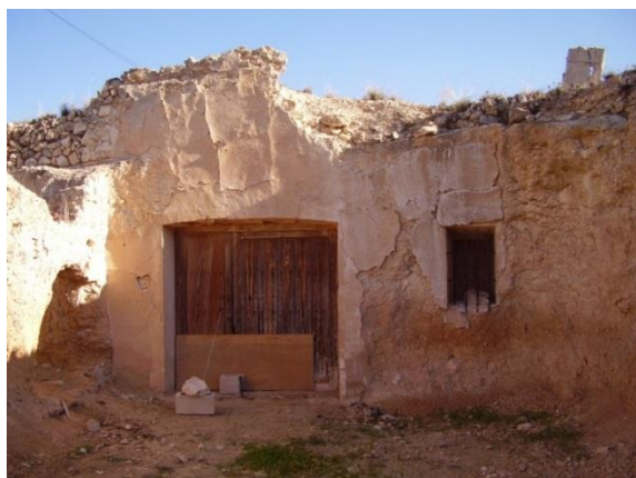
Figura 390. Disgregación del material de rejunto en fábrica de mampostería. Cueva 03_04_43 de Hondón de las Nieves
