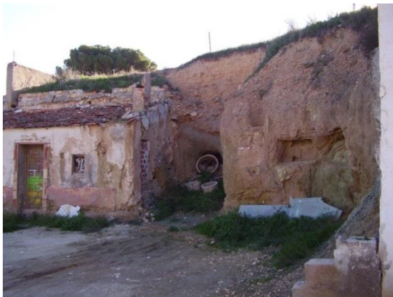
Figura 396. Pérdida parcial de la base del muro (terreno). Cueva 06_02_04 de Monóvar
