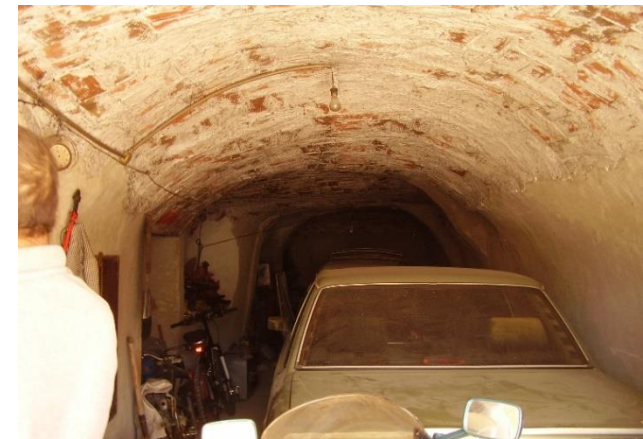
Figura 376. Refuerzo de bóveda con viguetas de troncos de madera. Cueva 04_03_08 de La Romana
