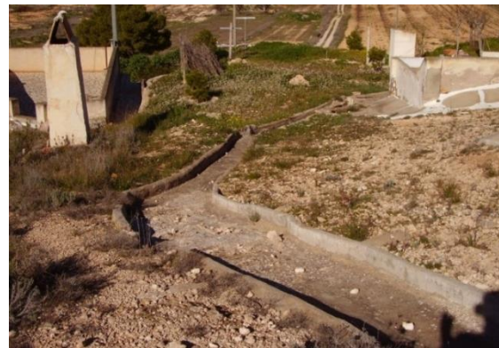
Figura 291. Instalación eléctrica en superficie. Cueva 01_02_03 de La Romana
