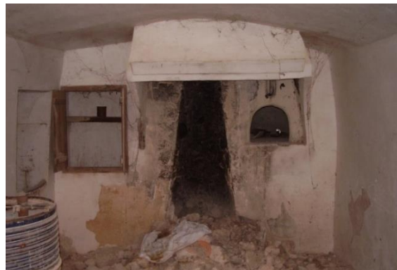
Figura 225. Detalle de moldura en chimenea. Cueva 01_08_64 de Pinoso
