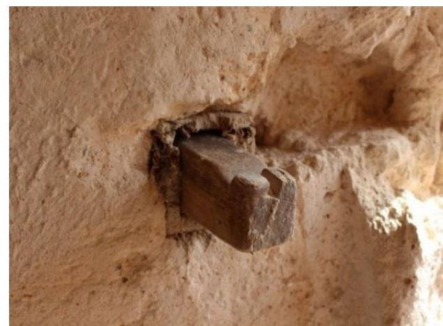
Figura 267. Sistema de cierre de portón de acceso. Cueva 13_04_36 de Monóvar
