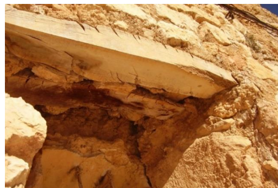
Figura 257. Dintel conformado por haz de cañas en hueco de acceso. Cueva 07_02_08 de La Romana
