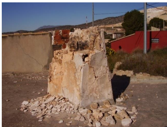
Figura 392. Derrumbe parcial de conducto de chimenea de mampostería. Cueva 03_04_50 de Hondón de las Nieves
