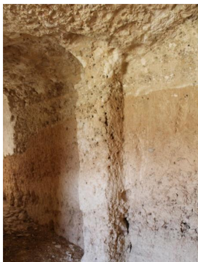
Figura 402. Deterioro y pérdida del acabado de barniz de la carpintería. Roturas. Cueva 13_04_36 de Monóvar
