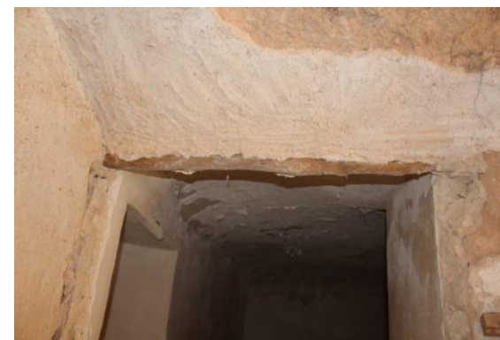
Figura 259. Tronco a modo de dintel en hueco de acceso. Cueva 06_01_03 de Monóvar
