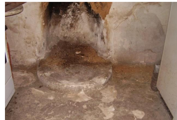
Figura 221. Arranque del tiro vertical en el techo. Cueva 07_02_08 de La Romana
