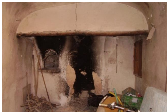
Figura 217. Chimenea prismática con remate de piezas cerámicas. Cueva 01_06_30 de Pinoso
