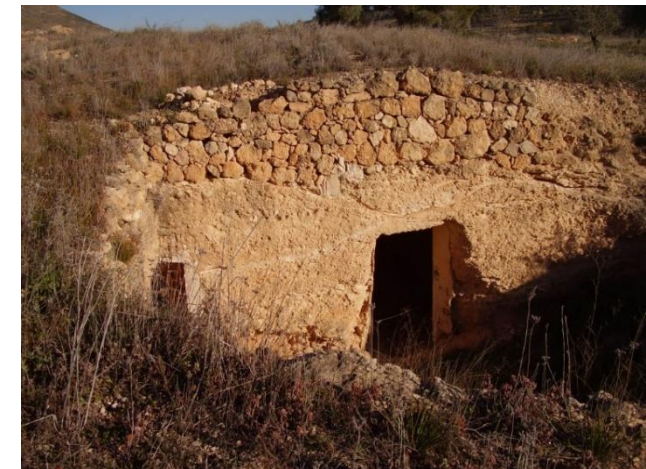
Figura 203. Antepecho como prolongación de la fachada. Cueva 02_01_21A de La Algueña
