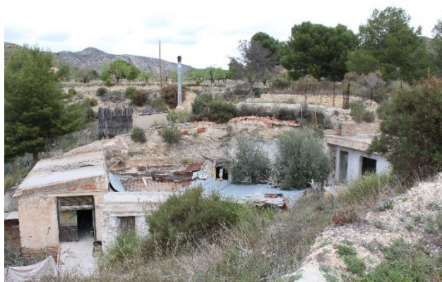
Figura 410. Chimenea sin remate. Cueva 07_01_06 de La Algueña
