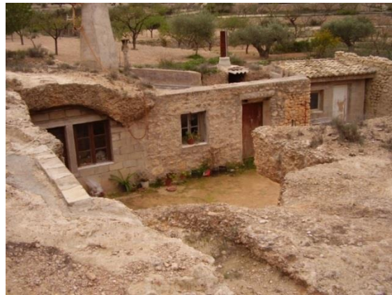
Figura 147. Acceso por camino excavado. Cueva 11_03_13 de Monóvar
