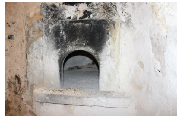
Figura 227. Chimenea y tiro embebidos en el terreno. Cueva 04_01_02 de Petrer
