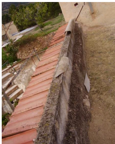
Figura 205. Muro de contención del terreno de piedra en seco. Cueva 03_04_53 de Hondón de las Nieves
