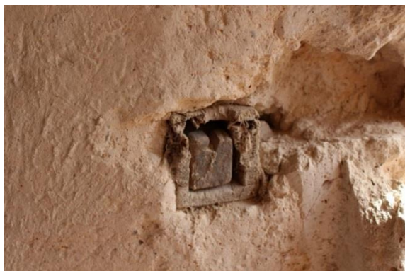
Figura 269. Anclaje y bisagra de portón de acceso. Cueva 07_01_03 de La Algueña
