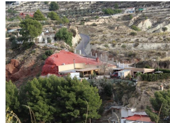
Figura 238. Cubierta natural en el núcleo Barrio Cuevas de Pinoso
