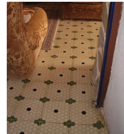
Figura 281. Pavimento de baldosas de barro cocido. Cueva 07_01_09 de La Algueña
