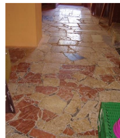
Figura 279. Pavimento contemporáneo de microcemento y baldosas cerámicas. Cueva 03_04_61 de Hondón de las Nieves
