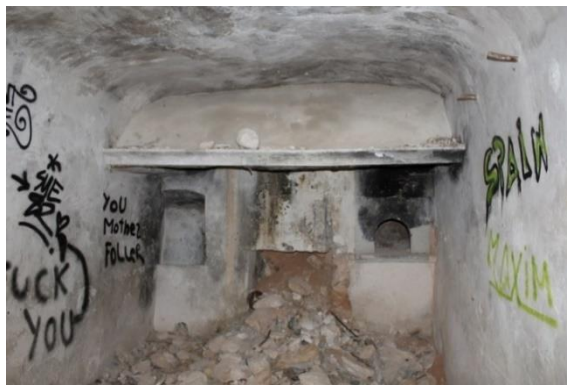
Figura 219. Chimenea y horno con tabique inclinado sobre vigas de madera. Cueva 07_02_08 de La Romana
