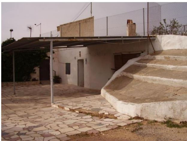
Figura 143. Acceso por cuña pequeña
