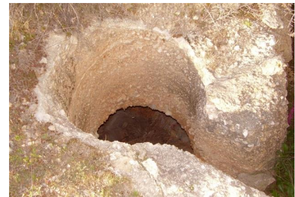
Figura 293. Canalización de agua por la cubierta. Cueva 13_04_26 de Monóvar
