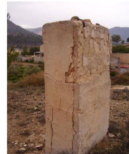
Figura 209. Remate del acceso con alero empotrado en terreno natural del frente. Cueva 06_02_05 de Monóvar
