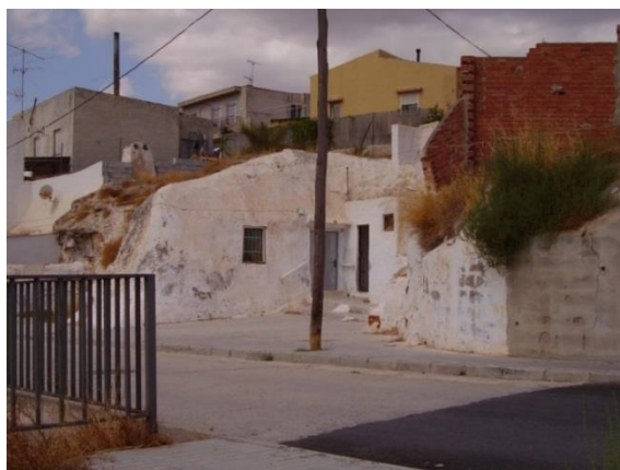
Figura 330. Frente con terreno directamente revestido en Crevillente
