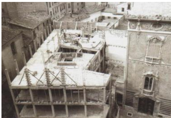
Ilustración 9: Construcción de una nueva ala en el exterior del Palacio.
