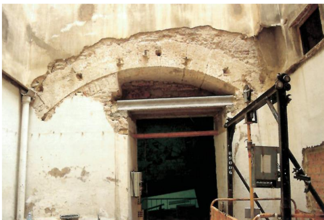
Ilustración 7: Arco carpanel hallado en el patio ocupado por la escalera actual
