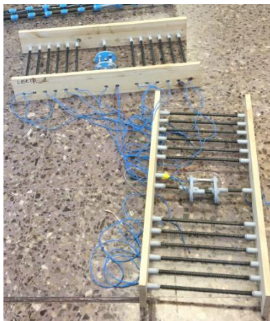
Imagen Nº 37. Disposición de armaduras en tablero de encofrado.
