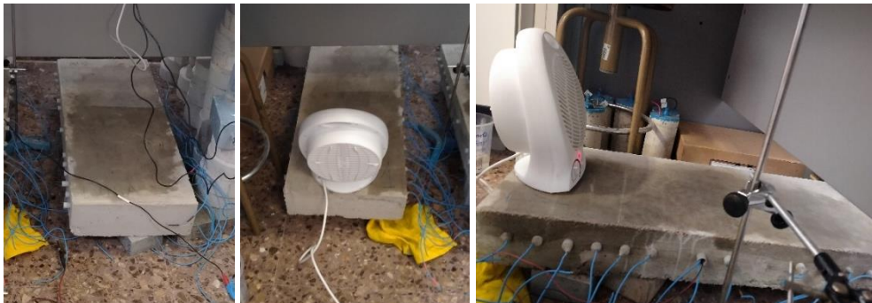
Imagen Nº 55. Fotografías de la limpieza de losa para garantizar adherencia de pondeo de tuberías de PVC.
