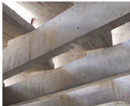
Imagen N° 8: Manchas de óxido en superficie
