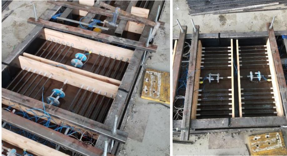
Imagen Nº 39. Losas de hormigón en encofrado metálico
