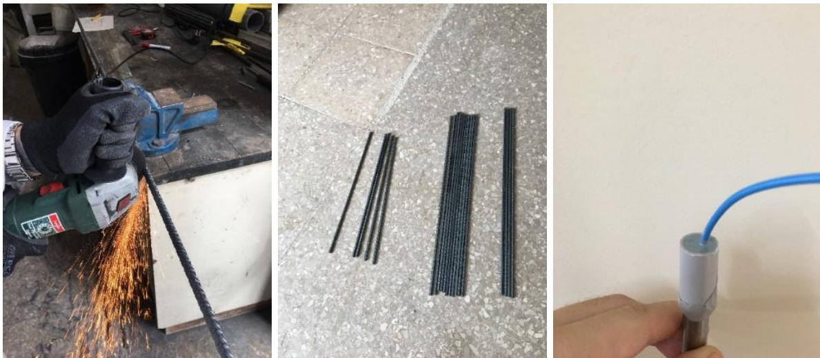
Imagen Nº 34. Fabricación de conexiones eléctricas para armaduras
