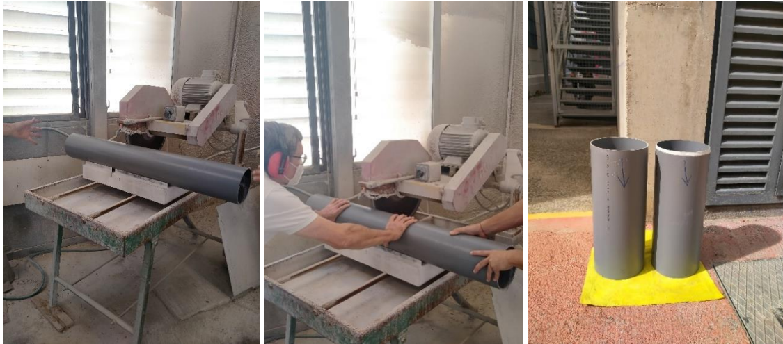
Imagen Nº 54. Fotografías corte de tuberías de PVC.
