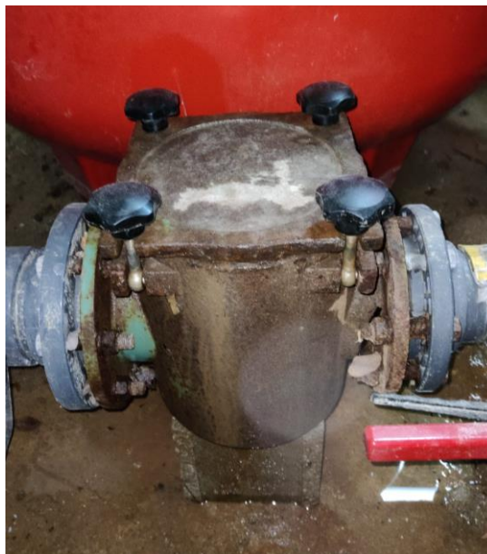
Figura 9 Prefiltro. Fuente: red hidráulica
