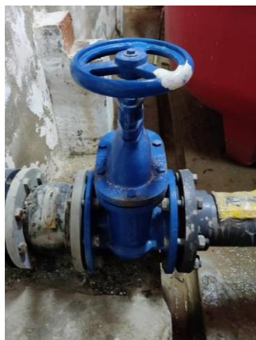
Figura 5 Válvula sumideros. Fuente: red hidráulica
