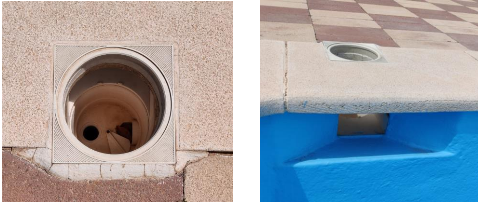
Figura 12 Skimmer. Fuente: red hidráulica
