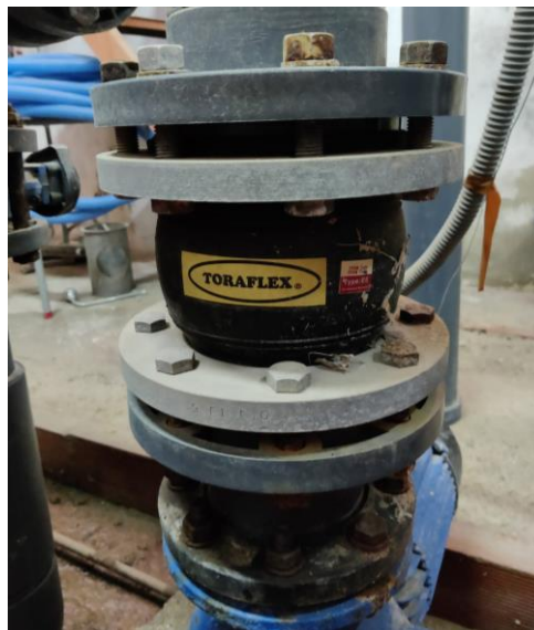
Figura 11 Manguito antivibratorio. Fuente: red hidráulica
