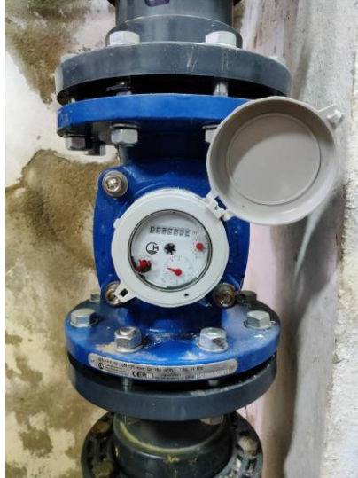
Figura 15 Caudalímetro. Fuente: red hidráulica
