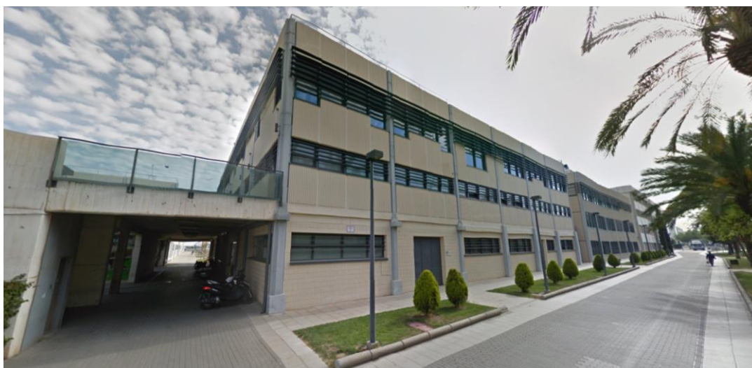
Figura 55. Edificios 5C y 5D
