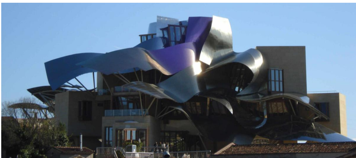
Figura 3. 12 Bodega del Marqués de Riscal. Proyectada por Frank O. Gehry
