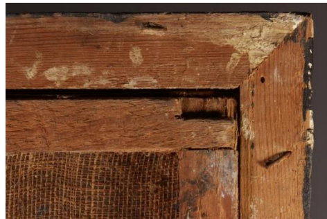
Figura 28. Pérdida de madera en la esquina del bastidor.
