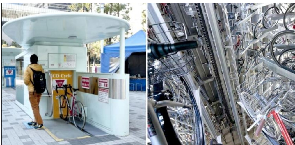
Ilustración 45. Parking de bicicletas subterráneo. Fuente: cycling.today.
