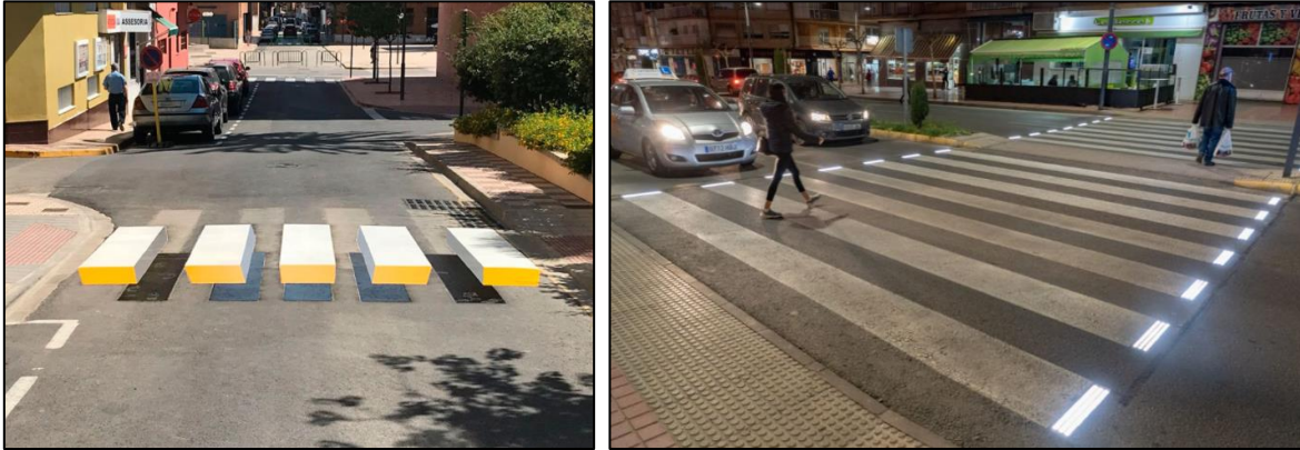
Ilustración 61. Paso peatonal tridimensional en Almussafes (izquierda). Fuente: TECNOL. Paso peatonal luminoso en Cartagena (derecha). Fuente: Ayuntamiento de Cartagena.
