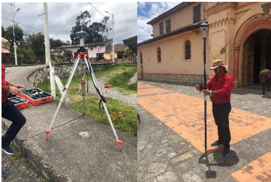
Figura 56. Base y Rover del RTK realizado (Fuente: Elaboración propia)
