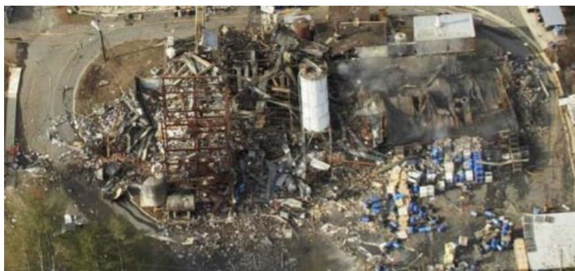
**Figura 1.6:** Explosión producida por la excursión térmica del reactor, (Gyenes 2017)
