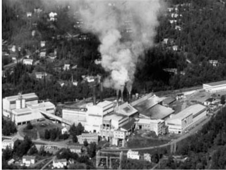
Figura 2.1 Emisión de humo de sílice de una industria de ferro-silicio en Estados Unidos antes de las regulaciones medioambientales durante los años setenta [16].
