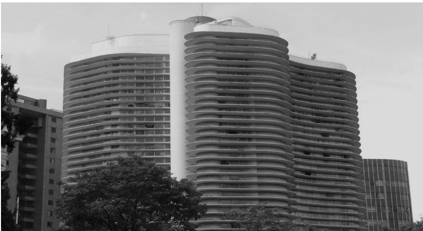
Fig. 54_Vista exterior del edificio de apartamentos.
