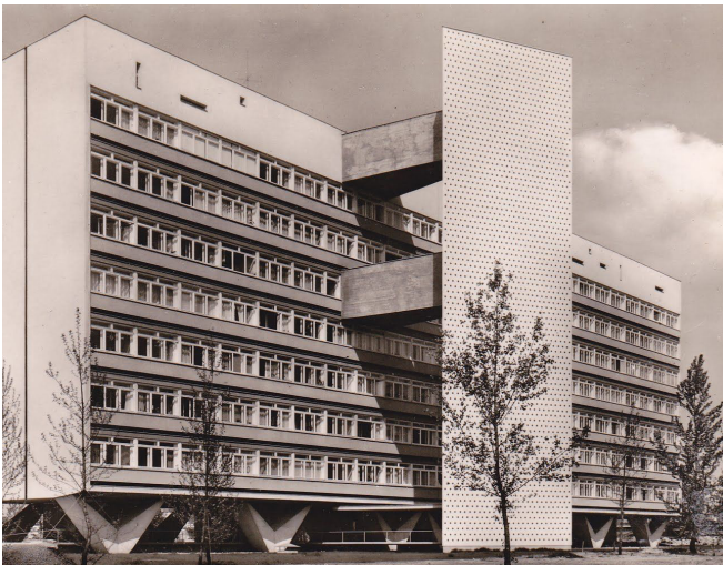
Fig. 66_Imagen exterior del edificio en el barrio de Hansaviertel.
