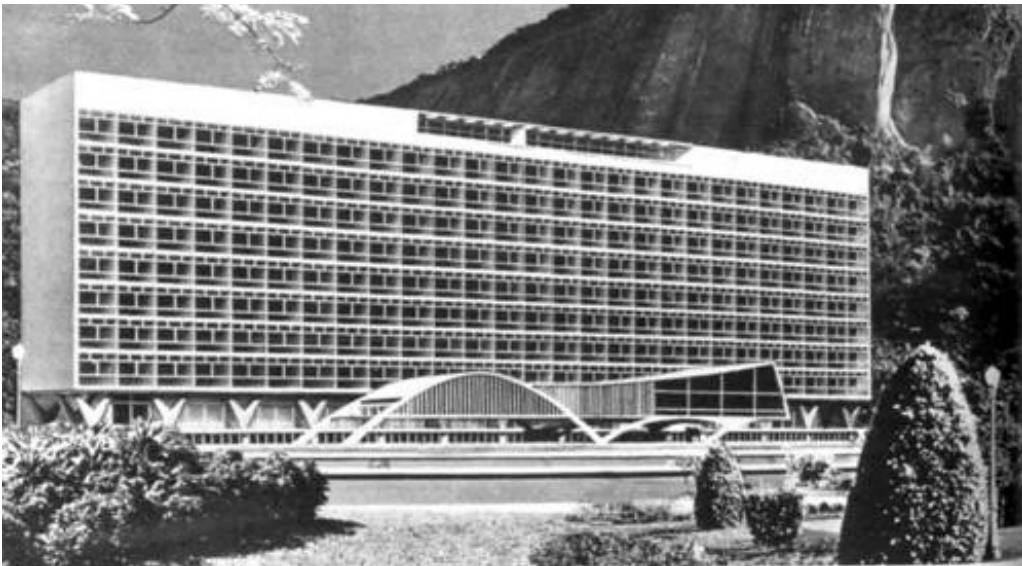
Fig. 78_Imagen exterior del Hospital Sul América .
