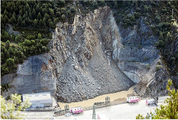
Figura 4: Deslizamiento de la Portalada (Andorra) del 10/08/2019. Fuente: Diari d'Andorra (2021).
