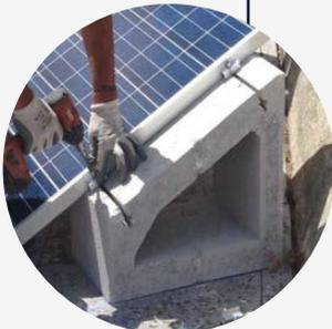
Cada soporte incluye los anclajes metálicos, necesarios para la fijación de los módulos.
