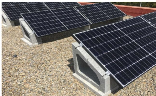
Figura 21. Estructura de hormigón Solarbloc
