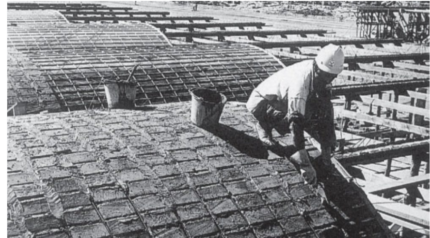
Figura 2.13 Construcción bóveda autoportante de los Pabellones de Comerciantes
