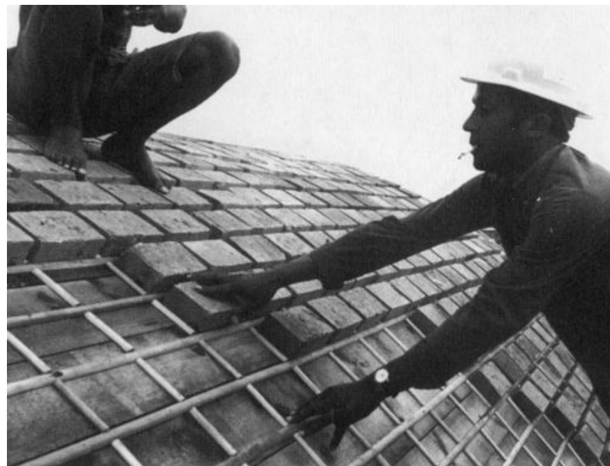
Figura 2.9 Construcción bóveda Gausa
