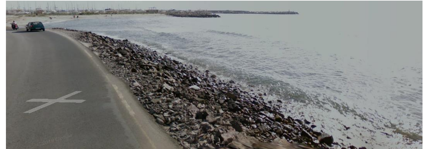
Figura 11. Estado actual del sur del Puerto de Siles (Fuente: Google Maps, 2021)
