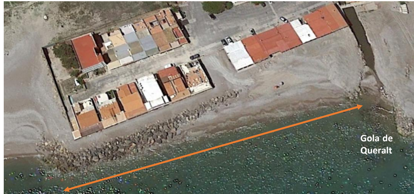
Figura 65. Escollera de protección viviendas en Corinto (Fuente: Google Earth Pro)
