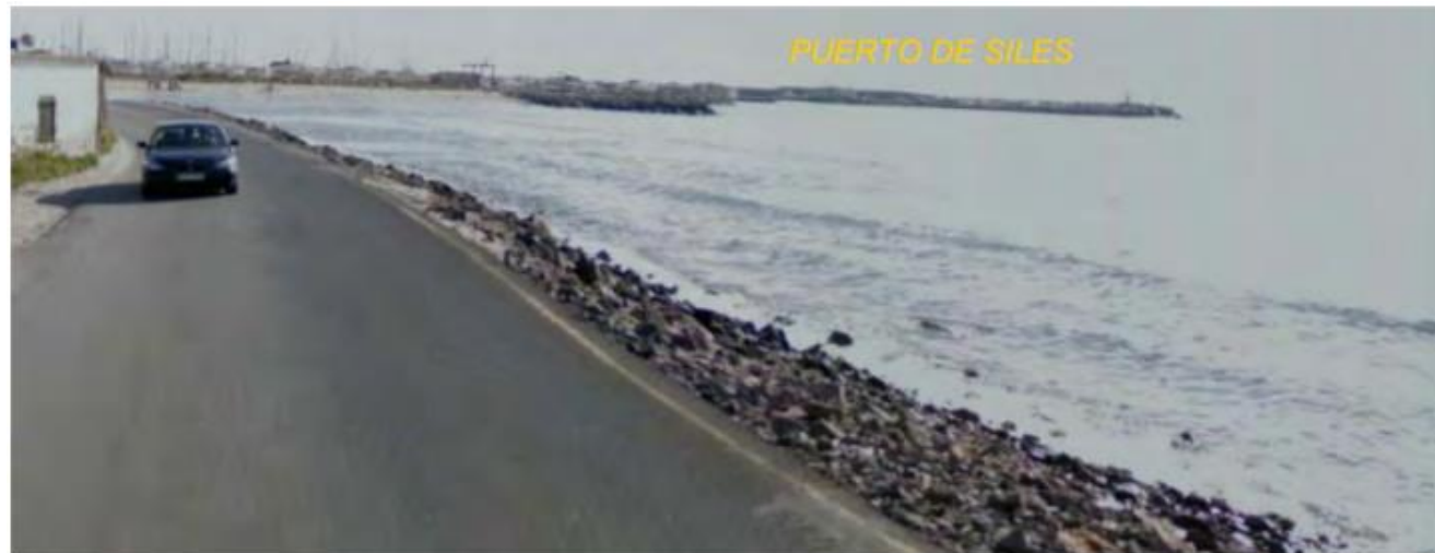
Figura 67. Escollera y bolos junto a la carretera en el Delta del Palancia (Fuente: IH Cantabria, 2011)
