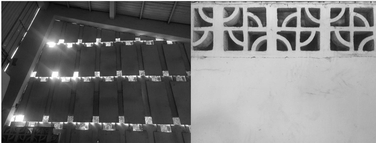
Fig. 71 | Sistema de protección solar Club de Leones, quiebrasol metálico y celosía de hormigón. Fuente: INPC, 2021.
