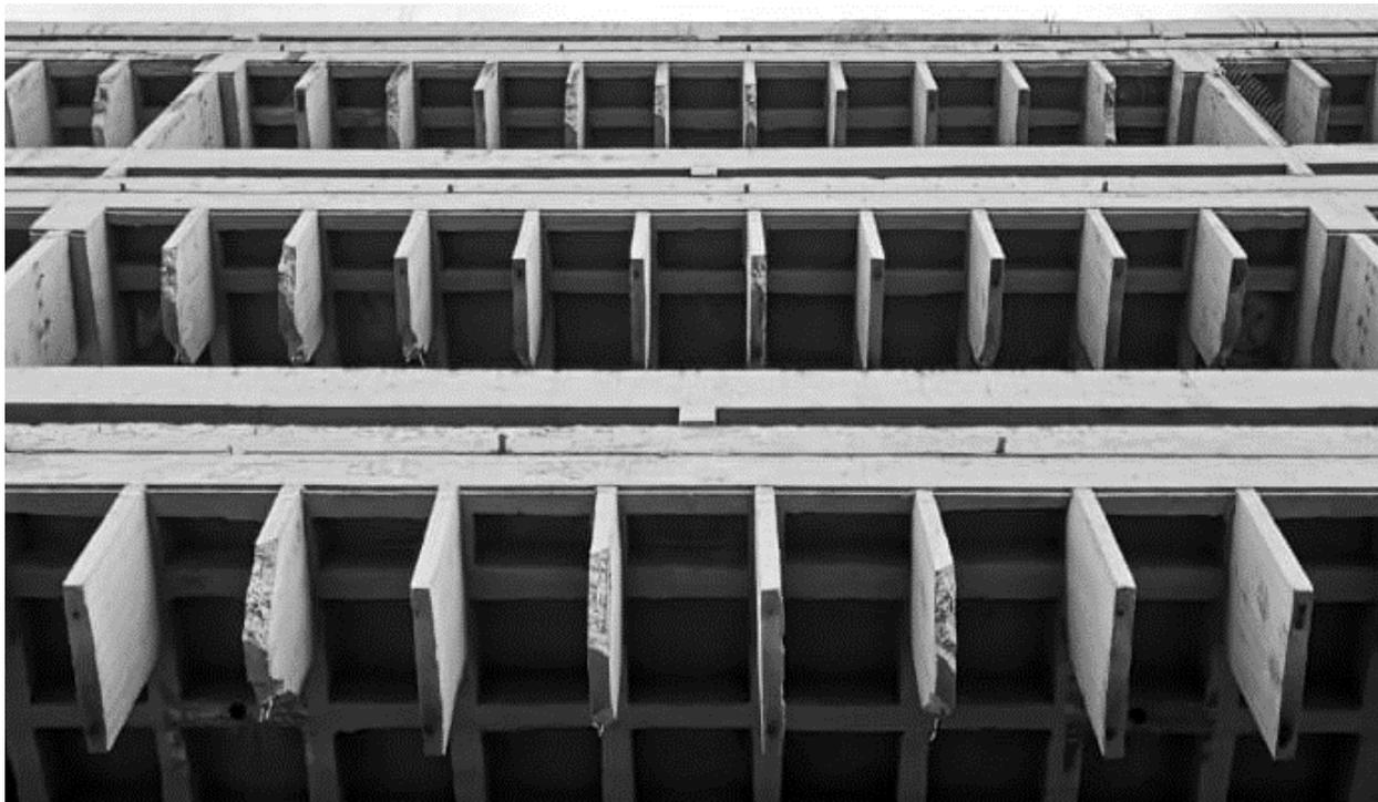
Fig. 77 | Imagen de quiebrasol de hormigón, MAG. Fuente: Elaboración propia, 2020
