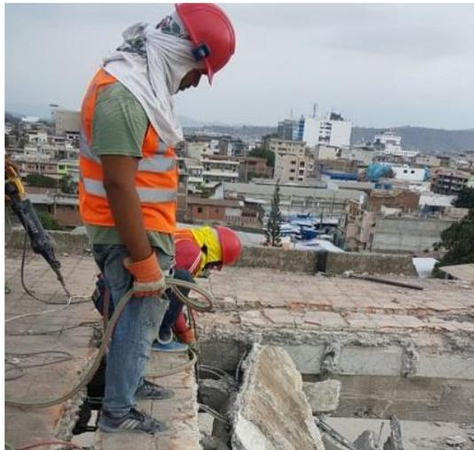
Fig. 169 | Colocación de anclajes para extracción de vigas. Ramón Muñoz, 2016.
