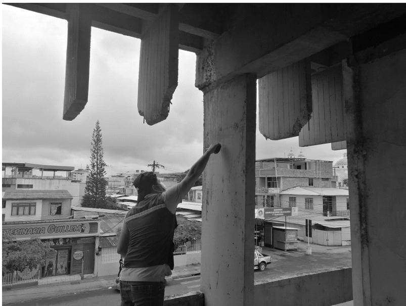
Fig. 19 | Medición de zona de apoyo de quiebra sol horizontal, fachada Este. Foto: Alejandro Rivera, 2021.
