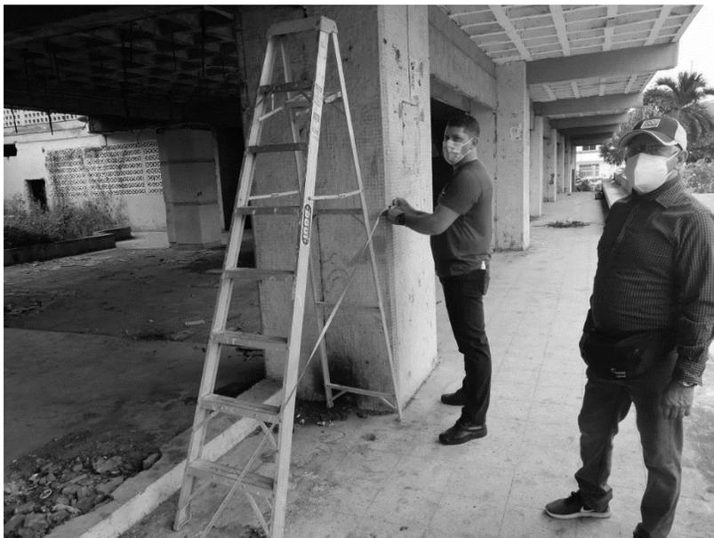
Fig. 15 | Medición de ejes de columnas en planta baja, fachada Este. Foto: Alejandro Rivera, 2021.
