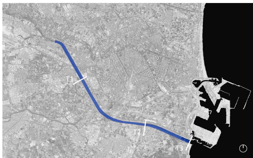
Figura 1. Nuevo Cauce del Río Turia. Planta general, con indicación de tramos, sobre ortofoto. Fuente: Rivera et al., 2018.
