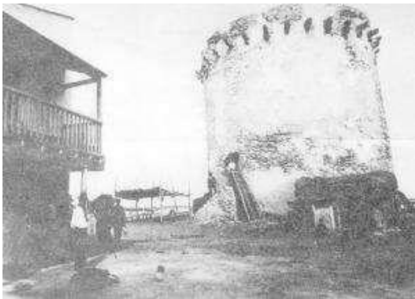
Figura 7: Fotografía de la torre de la Encañizada, (Guirao Girada, 1890)
