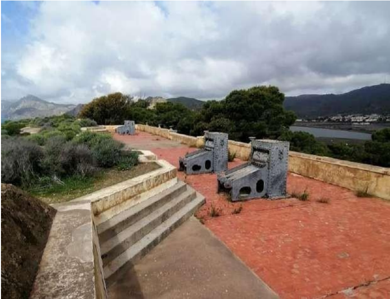
Figura 57: Montacargas en cubierta. (Senín, 2021)
