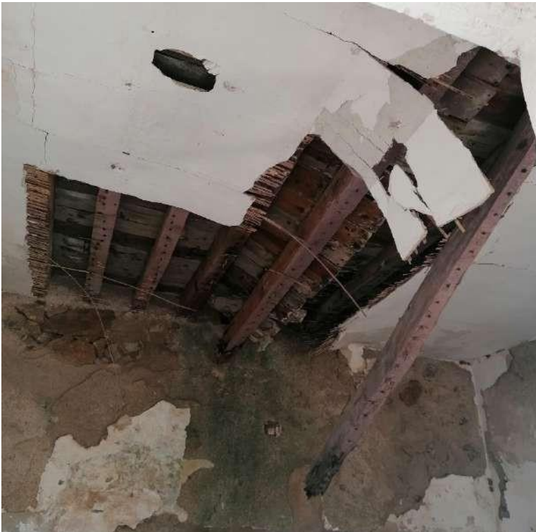
Figura 66: Imagen de la cubierta de madera con viguetas del mismo material del edificio preexistente y anexo al conjunto cantina-comedor-cocina. (Senín, 2021)
