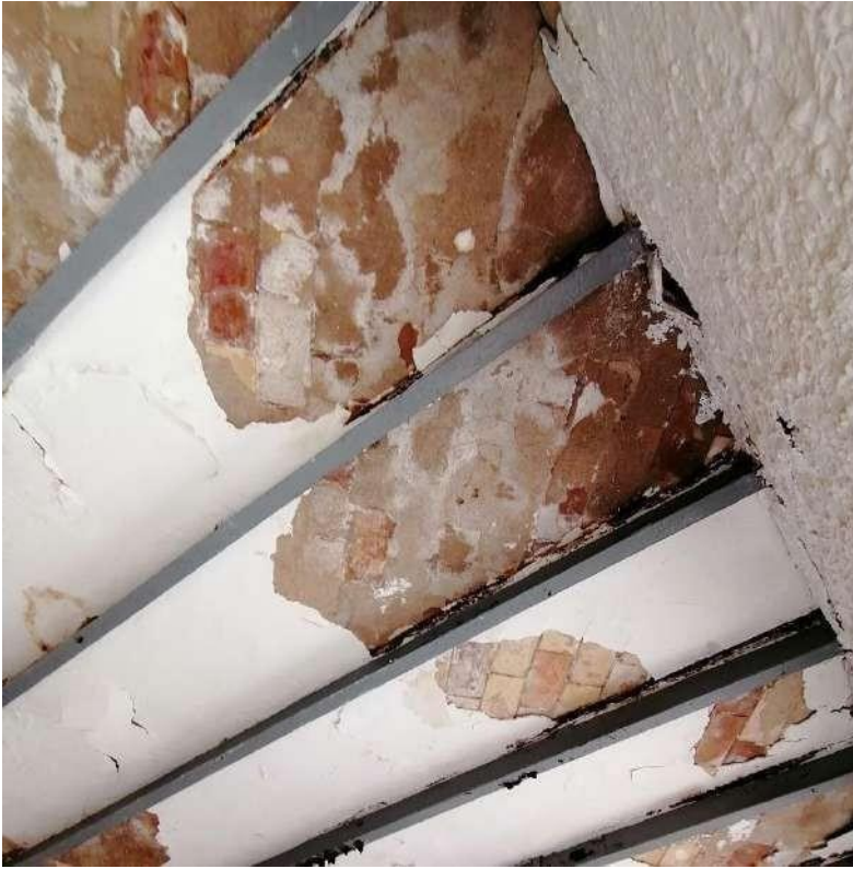
Figura 65: Cubierta de viguetas metálicas y ladrillo macizo con revestimiento de yeso para la cocina y letrinas del del edificio conjunto, cantina-comedor-cocina. (Senín, 2021).
