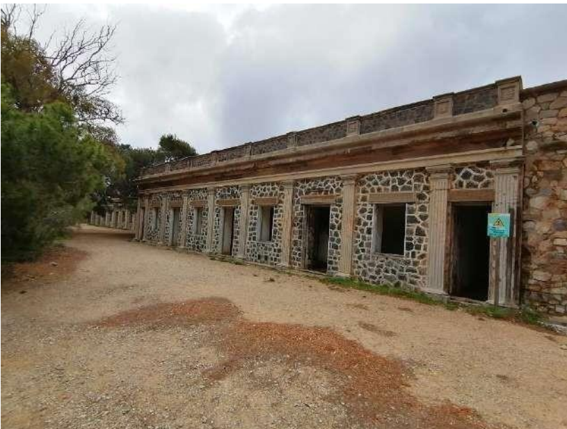
Figura 52: Edificio de repuestos de la pieza n.º 2. (Senín, 2021)
