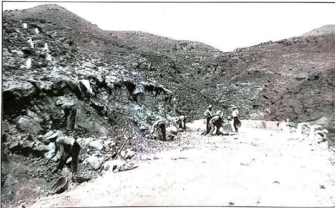
Figura 54: Reforma del camino desde el muelle de Portman, julio de 1930. (Valderas Ruíz, 2002)
