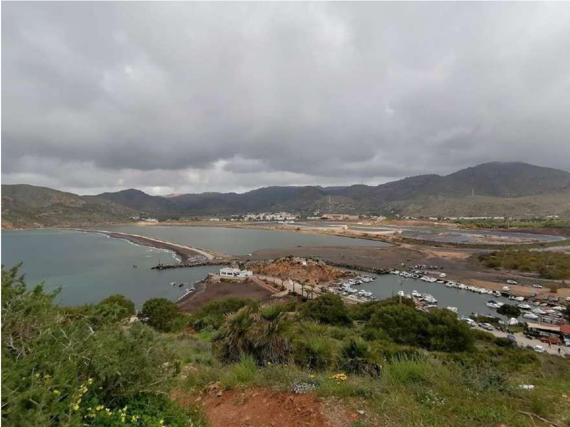
Figura 48: La bahía de Portman desde el faro, apréciase el pequeño puerto de pescadores y las obras de la Regeneración de la Bahía detrás. (Senín, 2021)
