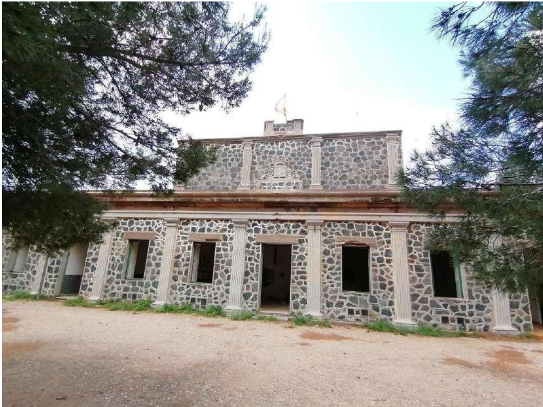
Figura 44: Oficinas y residencias de la Batería de La Chapa. (Senín, 2021)
