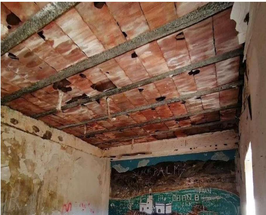
Figura 64: Cubierta de viguetas metálicas y bovedillas ligeras de la cantina y comedor del edificio conjunto cantina-comedor-cocina. (Senín, 2021)
