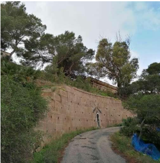
Figura 50: El muro de contención y por encima los primeros locales del conjunto. (Senín, 2021)
