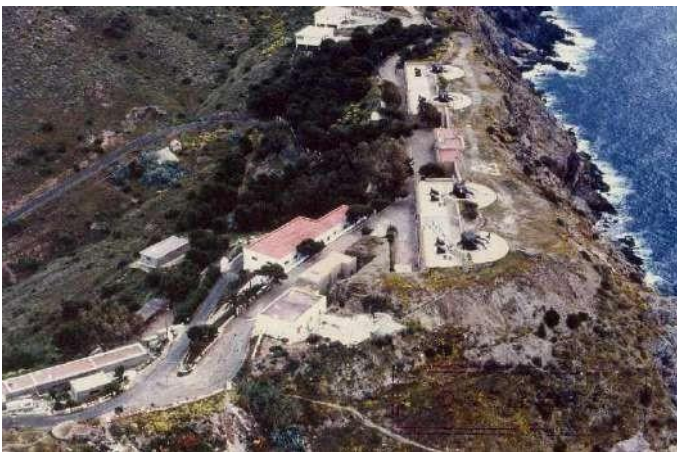
Figura 55: Imagen aérea de la batería de La Chapa. (aforca.org)
