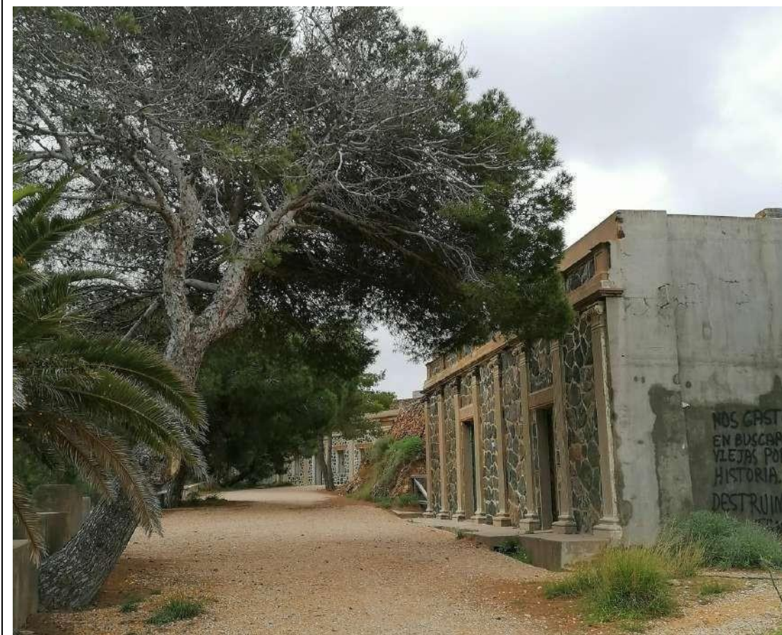
Figura 46: Pabellón Capitán y sala de máquinas a la derecha. (Senín, 2021)
