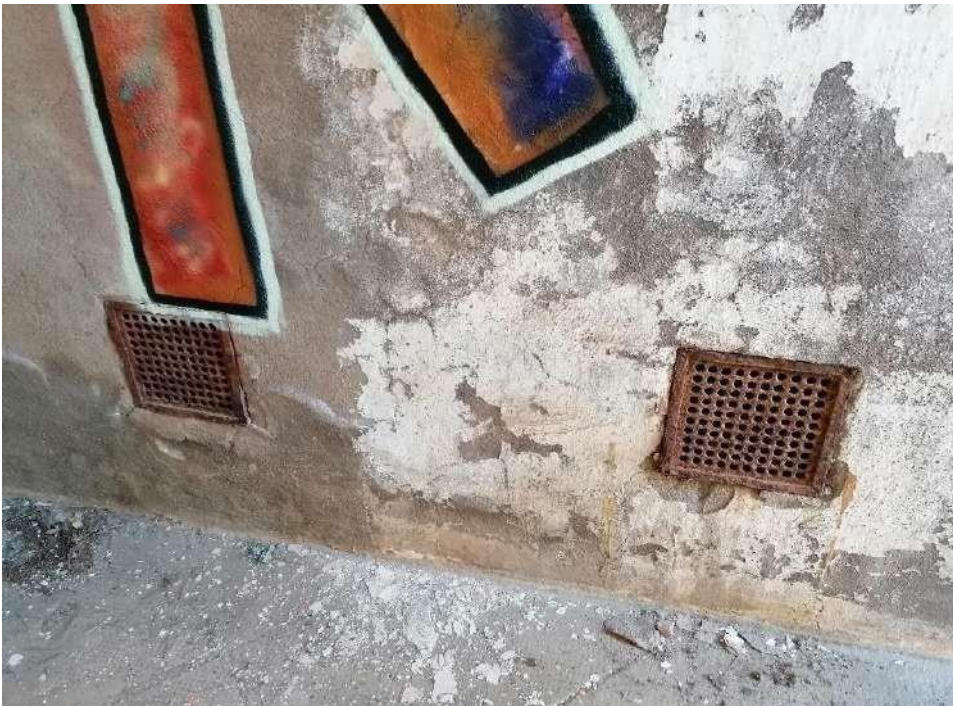
Figura 56: Rejillas de ventilación que comunican los locales con los corredores/galerías de ventilación. (Senín, 2021)
