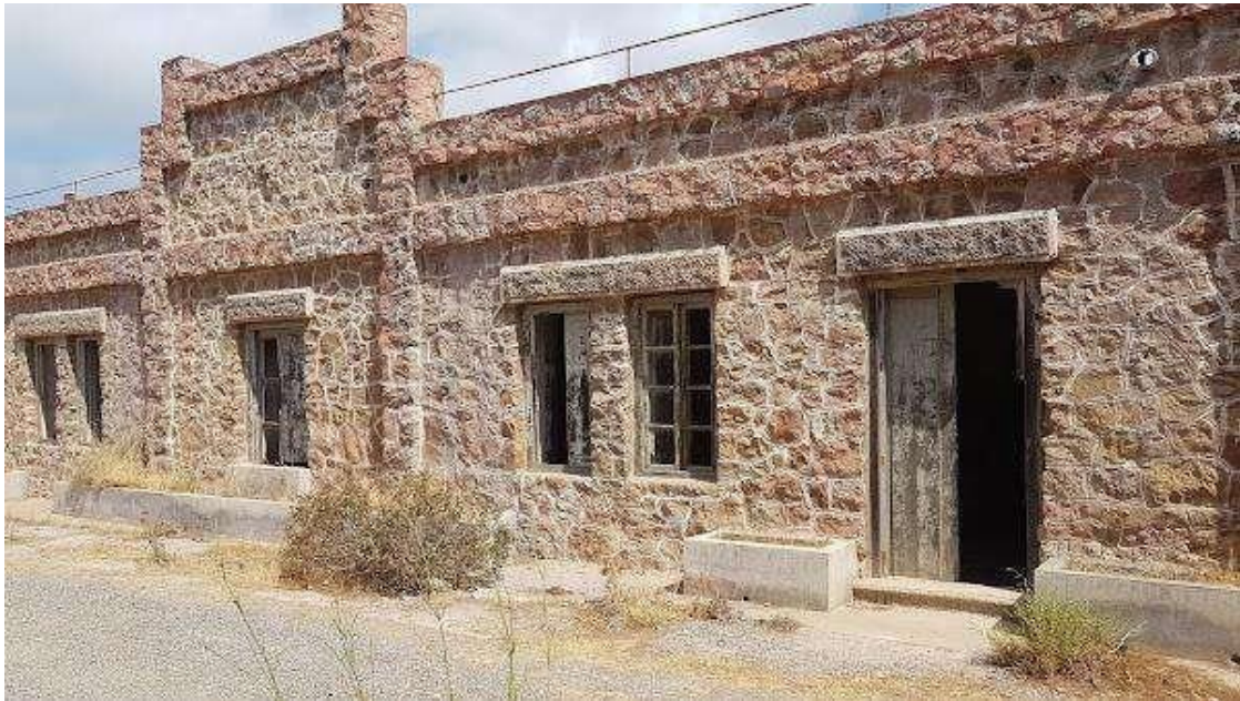
Figura 43: (batería de Aguilones).
