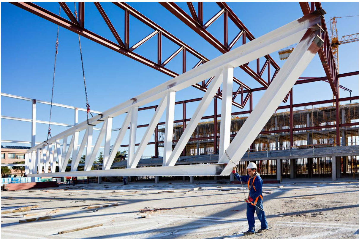
Figura 30. Callejas, J. (2016). Colocación cerchas Pabellón UFV. [Fotografía]. https://www.campobaeza.com/es/sports-pavilion-university/
