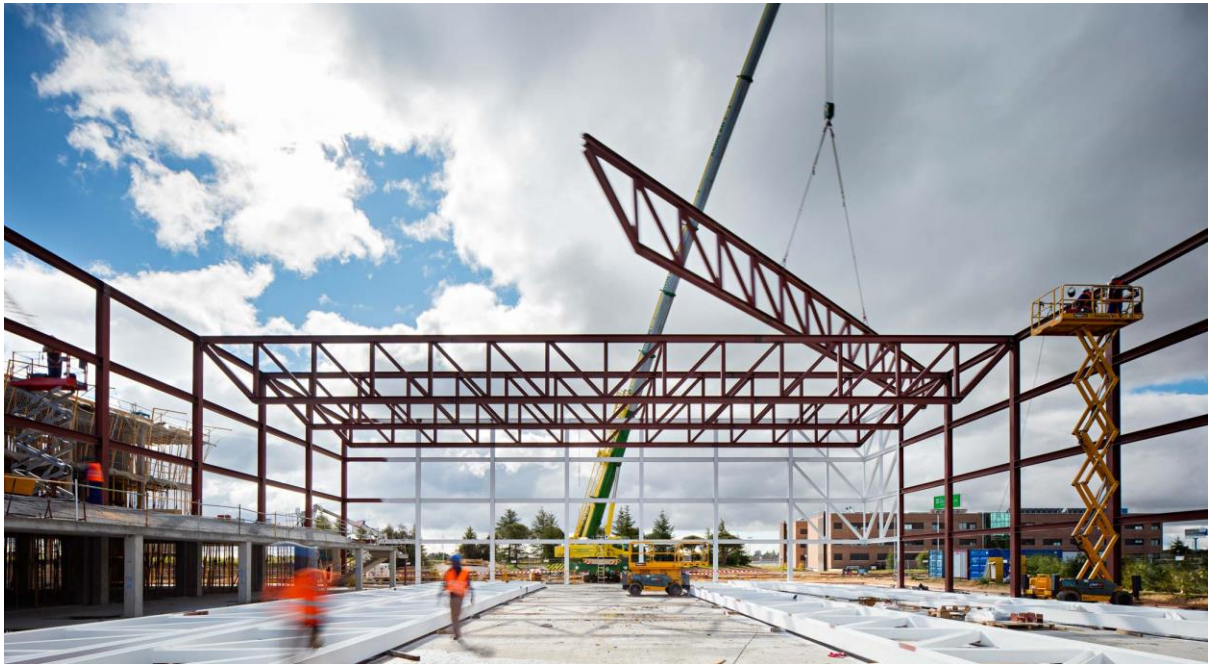
Figura 29. Callejas, J. (2016). Colocación cerchas Pabellón UFV. [Fotografía]. https://www.campobaeza.com/es/sports-pavilion-university/
