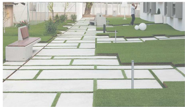
Suelo vegetal intercalado en pavimento
