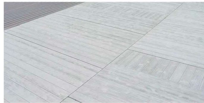
Pavimento exterior granito antideslizante de dos formatos (42x130 y 130x170 cm)
