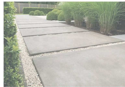
Gravas y áridos intercalados en pavimento
