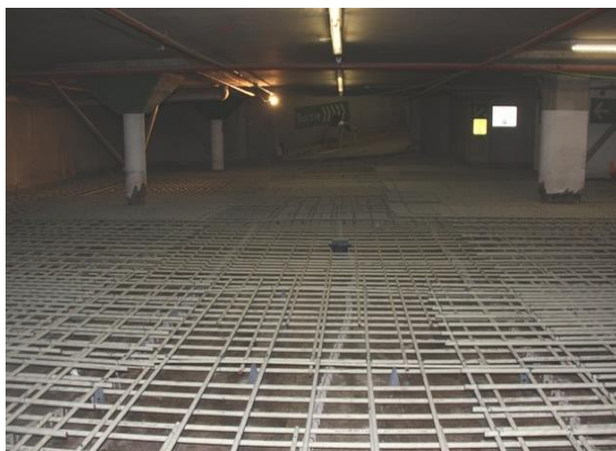
Fig. 26. Colocación del armado de refuerzo de GFRP.
