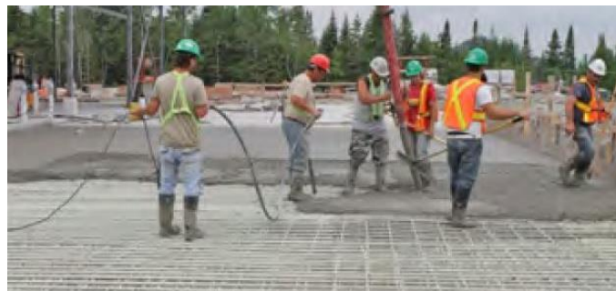
Fig. 22. Hormigonado de la losa general de cubierta.
