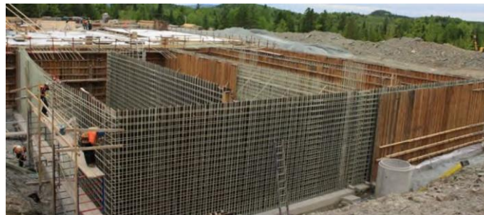
Fig. 21. Encofrado de los refuerzos verticales de barras de GFRP
