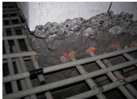
Fig. 27. Anclaje de las barras de GFRP en elementos estructurales.
