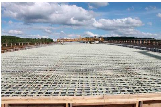
Fig. 30. Armado de refuerzo híbrido con barras de GFRP y acero galvanizado.
