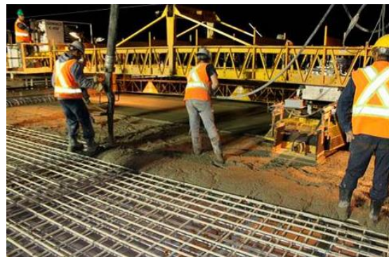
Fig. 31. Hormigonado de la losa híbrida del puente de Sainte-Catherine.
