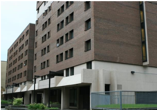
Fig. 23. Edificio residencial sobre el aparcamiento de La Chancelière
