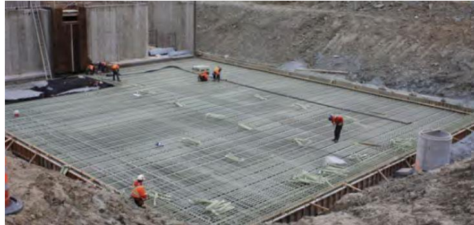
Fig. 20. Refuerzo de los cimientos mediante barras de GFRP.
