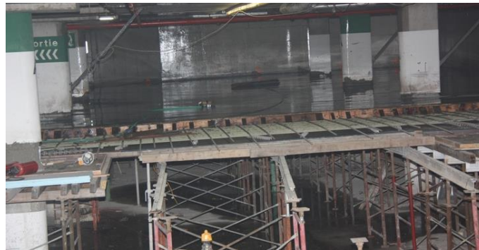
Fig. 25. Demolición de la losa antigua para colocación de nuevo armado.
