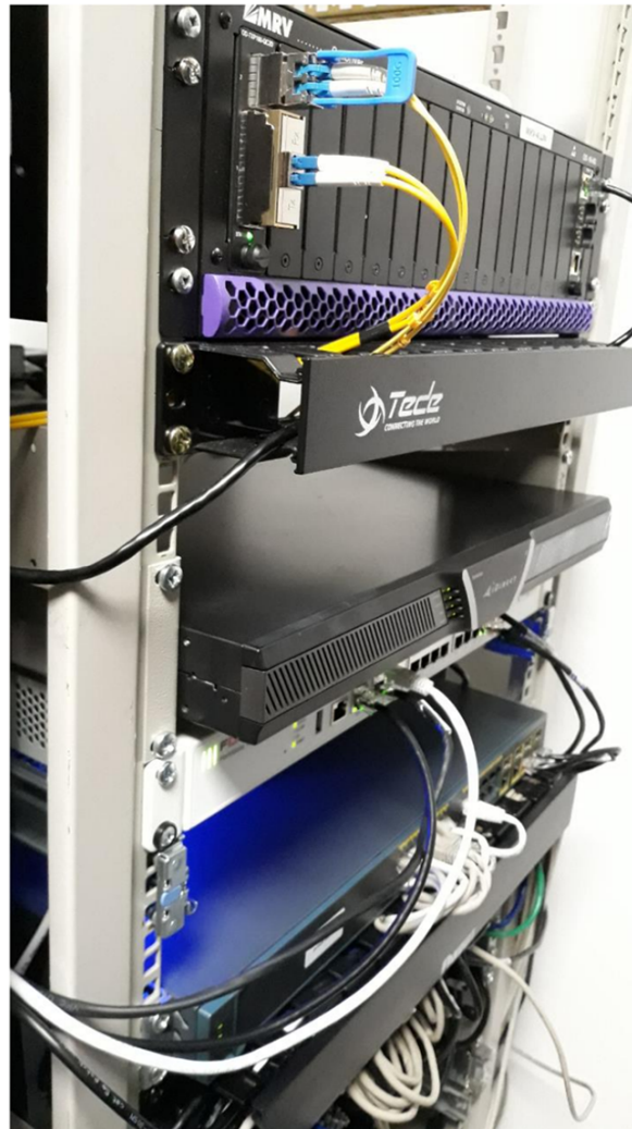
Figura 5.6: Equipos que implementan el núcleo de red de la plataforma de Limasol.
