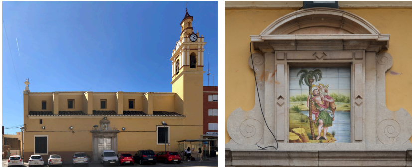
Figuras 41 y 42. Imagen de la fachada lateral (norte) de la Iglesia de San Cristóbal Mártir (izq.) y panel cerámico sobre la puerta lateral (der.) (En: Fuente propia).
