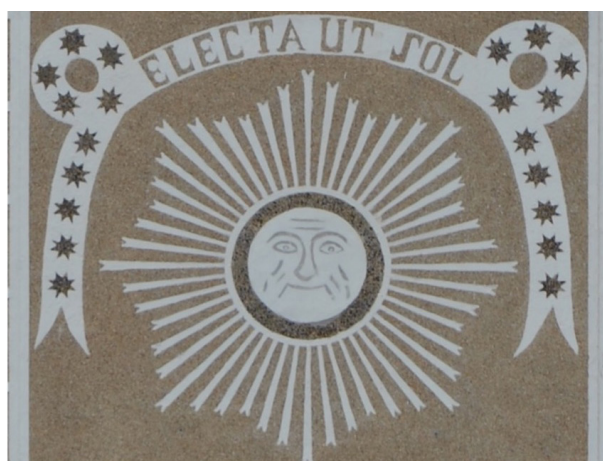
Figura 30. Detalle de la fachada de la Ermita de la Virgen de Vallivana (En: Fuente propia).
