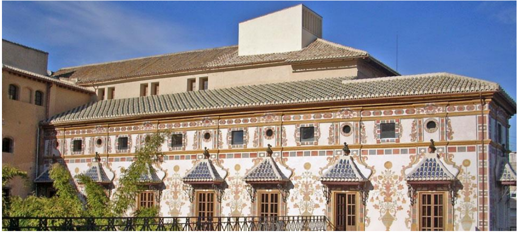
Figura 5. Vista exterior de la fachada de la Galería Dorada.
