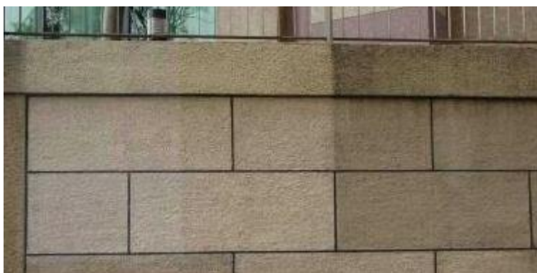
Figura 19: Ejemplo del efecto autolimpiante de una pared con material fotocatalítico y sin material fotocatalítico tras 3 semanas desde la aplicación del producto (146)
