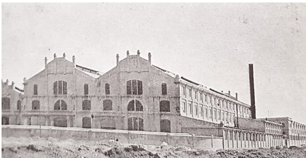
Fig.14. Fotografía de las naves de maquinaria, obtenida del libro UNION NAVAL DE LEVANTE S.A. 1924 - 1949
