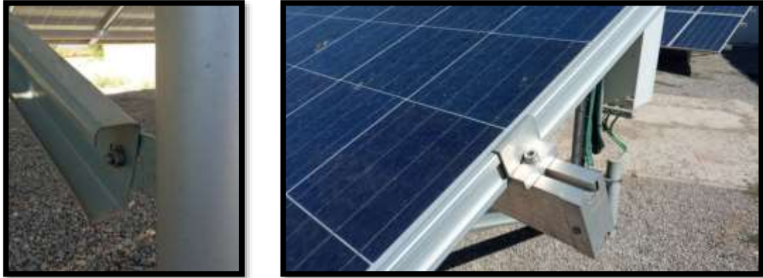
Figura 8. Diagonal tipo CF (izq.) y correas perfiles 41/41 (der.).
