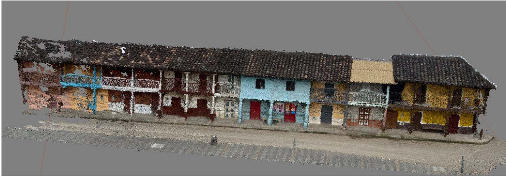
Fig. 10 Nube de Puntos densa de las fachadas de Cochapata.
