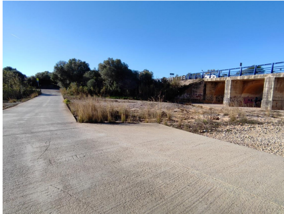
Foto Nº 4. Camino secundario sobre el barranco, aguas arriba de la actuación.
