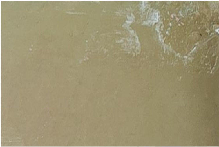
Imagen 255 - (Fragmento) – En ocasiones, el desmoldeante se acumula en las esquinas del molde, provocando estas formas.
