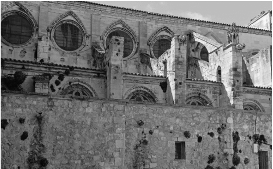
Figura 3.25. Arbotantes de la fachada de la catedral. Fotografía propia
