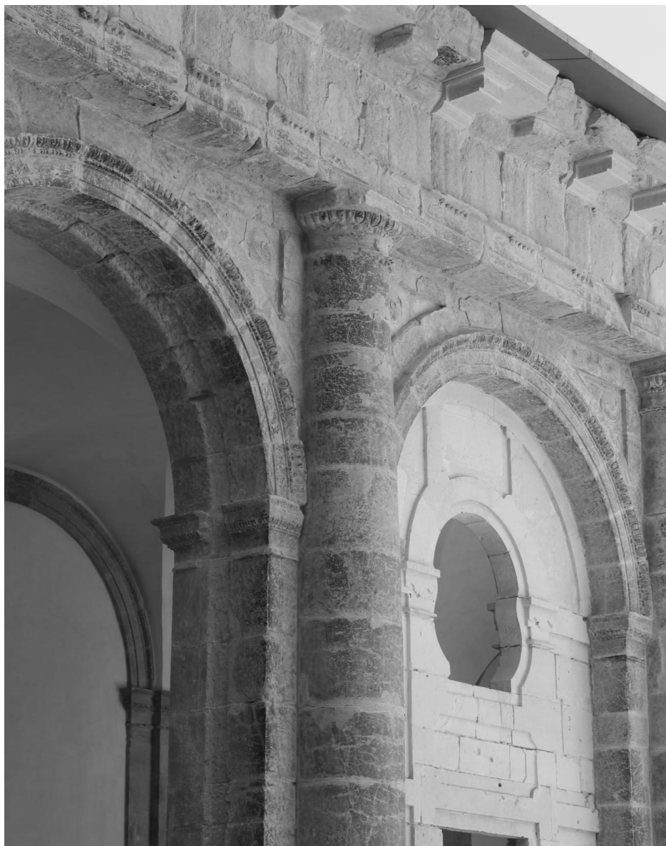
Figura 3.42. Detalle materialidad del claustro. Fotografía propia.
