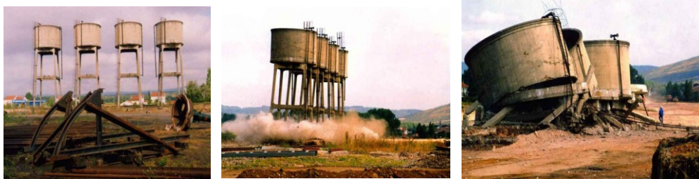
Fig. 76. Referente fotográfico de la serie Demolición .
