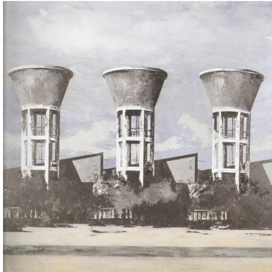
Fig.37 Antonio Alcaraz, Deposito PRODERAC. Valencia, 1997.
