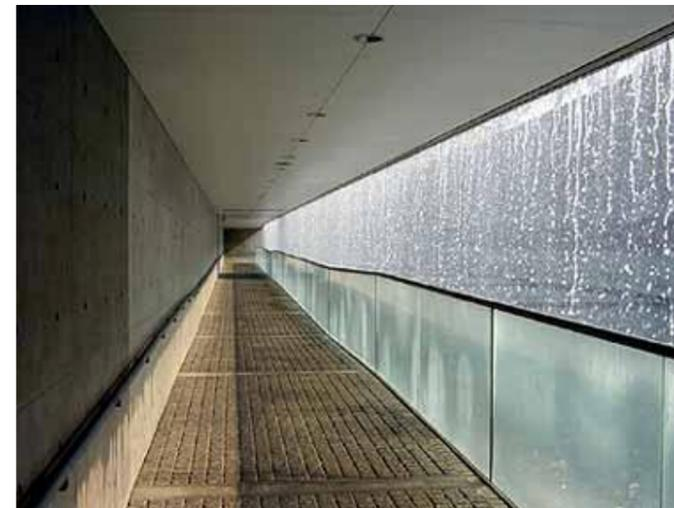
Estos ejemplos de la arquitectura monolítica de Tadao Ando muestran la fuerza visual que otorgan los grandes paramentos de hormigón visto, donde deja las marcas de los encofrados para favorecer el ritmo con un despiece reconocible y dando una textura interesante al muchas veces frío hormigón. El contraste con los huecos y paramentos de vidrio es así evidenciado permitiendo llamar la atención sobre estos puntos.
