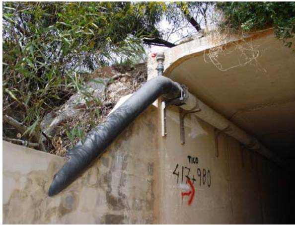
Figura 2.38. Ventosa en un sifón.
