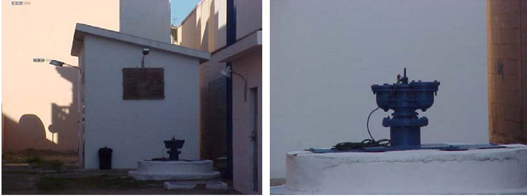
Figura 2.1. Utilización de una ventosa trifuncional en un pozo
