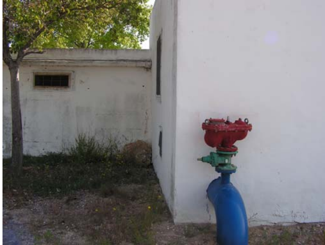
Figura 2.3. Ventosa en depósito
