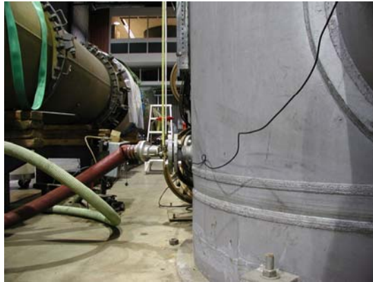
Figura 3.11. Tubo piezométrico en depósito 1
