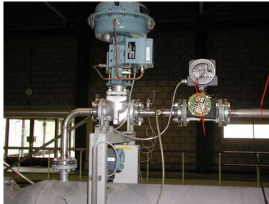
Figura 3.9. Caudalímetro tipo Vórtex DN25 en By-Pass
