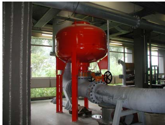
Figura 3.39. Depósito de agua
