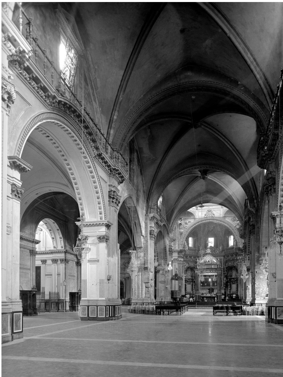
Figura 1.8. Interior de la Catedral de Valencia después de la intervención de Vicente Traver Tomás, 1955 (Archivo Gudiol 36419, Institut Amatller d'Art Hispànic).
