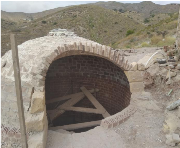
Ilustración 67_ Ejecución de la cúpula. https://www.carlospardo.es/2020/09/18/construccion-de-un-aljibe/
