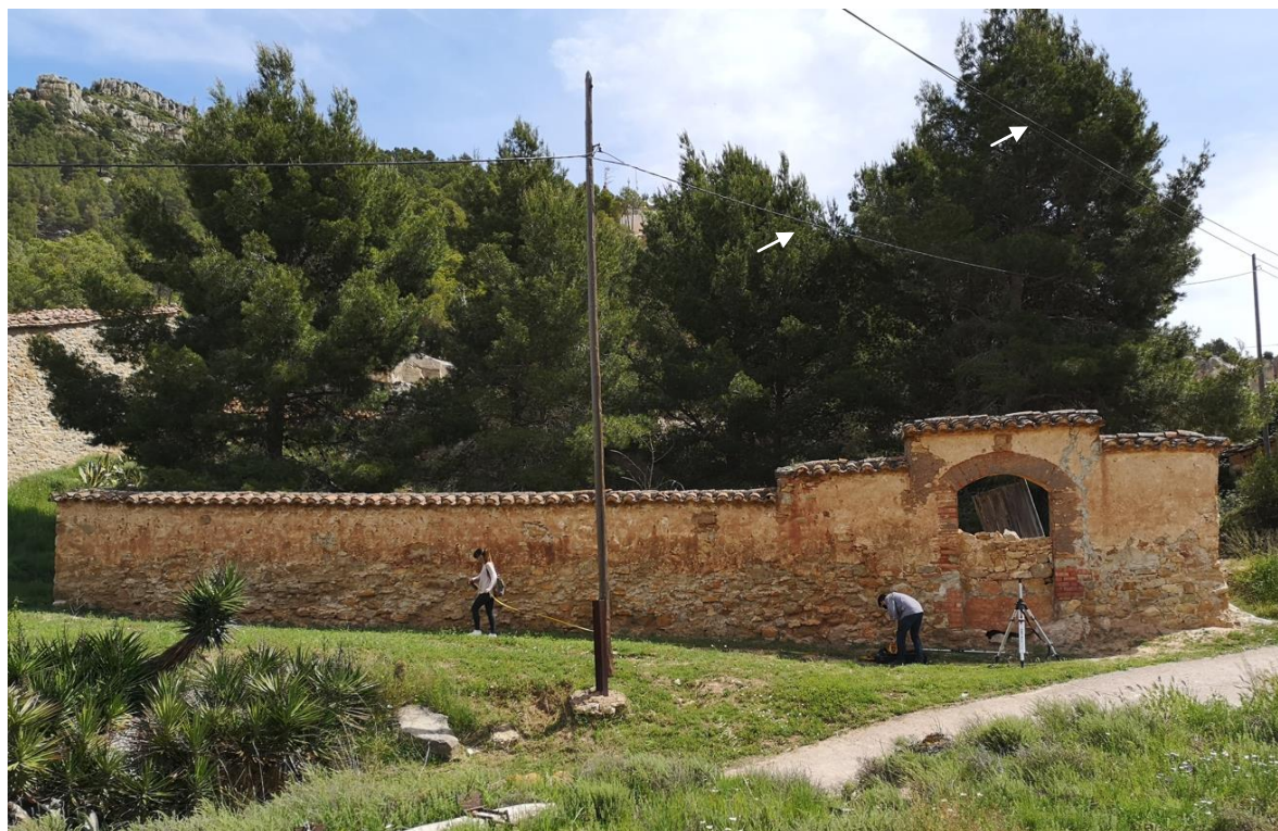
Ilustración 2 Líneas eléctricas en tensión. Fuente propia
