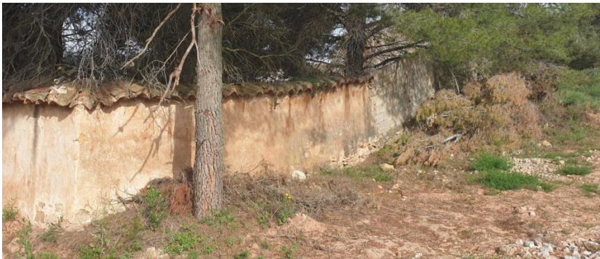
Ilustración 18_ Fotografía estado actual vista exterior fachada Norte. Fuente propia.
