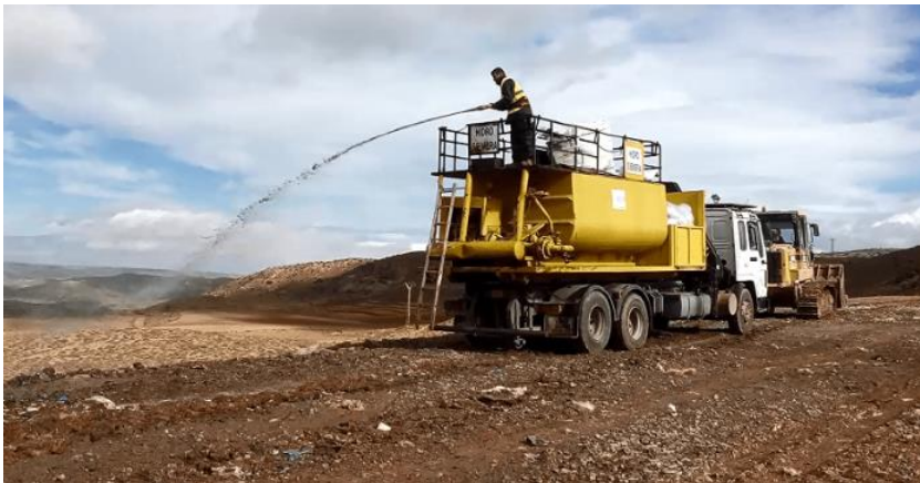
Ilustración 61_ Gunitado de material para hidrosiembra.
