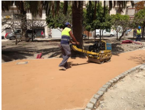
Ilustración 49_ Operación de compactación con medios mecánicos. https://www.paviprint.com/portfolio/compactacion/
