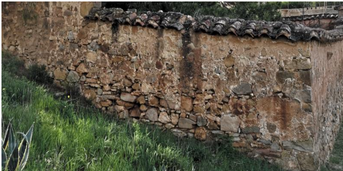
Ilustración 48_ Muro oeste – apertura de puerta de servicio. Fuente propia.
