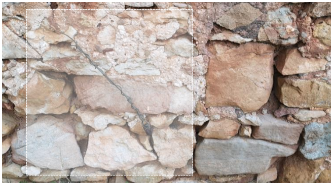
Ilustración 22_ Lesión 2_ Oxidación de elementos impropios de naturaleza metálica. Fuente propia.
