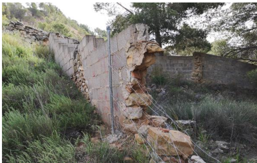
Ilustración 47_ Fábrica de bloque a demoler en muro oeste. Fuente propia.
