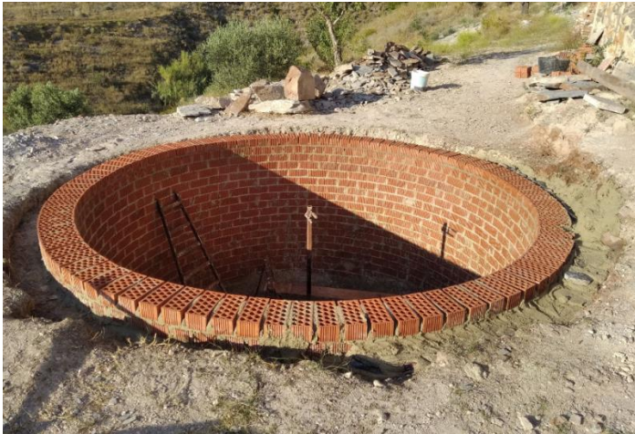
Ilustración 65_ Ejecución de fábrica de ladrillo para vaso de aljibe. https://www.carlospardo.es/2020/09/18/construccion-de-un-aljibe/
